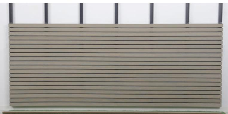
Otra cosa que puede suceder en los perfiles de fachada, debido a la natural variación dimensional provocada por la dilatación y contracción del perfil por los cambios de su temperatura, es que se produzca un desplazamiento lateral incontrolado de cada uno de los perfiles, provocando desajustes de linealidad en los extremos.
