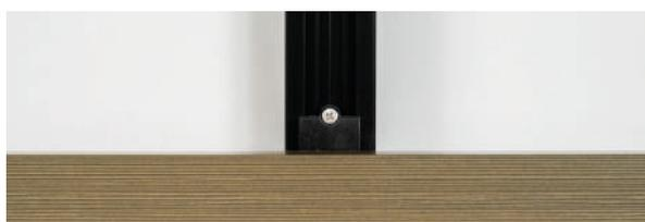
Una vez colocado el primer perfil, seguimos colocando los perfiles siguientes del mismo modo, sin emplear tornillos de fijación. Llegados a la fila 10, volveríamos a colocar tornillo de fijación para garantizar la horizontal y evitar así, un “efecto abanico” en filas superiores. Repetiríamos, de igual modo, cada 10 filas. p.e. Fila 10, Fila 20, etc...
