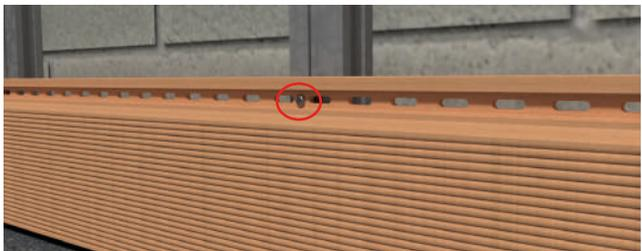
El resto de tornillos se fijarán utilizando un par de apriete que garantice la sujeción, pero que no embuta el tornillo, ya que, con los tornillos fijados de este modo, se permite la normal dilatación y contracción de los perfiles, pero evitamos el desplazamiento lateral de la pieza.
