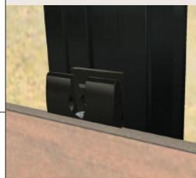
Este sencillo sistema, permite la dilatación y contracción de la pieza, pero evita que debido a estas dilataciones y contracciones, la pieza se pueda ir desplazando lateralmente, provocando que, además de variar el aspecto visual de la fachada, alguna testa pueda perder el contacto con el clip.
