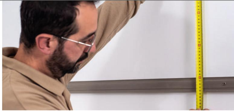
Los rastreles se fijarán al sustrato mediante la fijación mecánica apropiada. La separación de estas fijaciones mecánicas no será superior a 750 mm. Si un rastrel tiene una longitud inferior a 750 mm, llevará, al menos, dos fijaciones.
