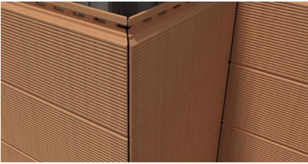
Llegado a la última fila de la instalación, nunca se puede terminar la instalación con pieza completa, por lo que la última pieza colocada, se deberá cortar longitudinalmente al ancho necesario, según el espacio disponible.
