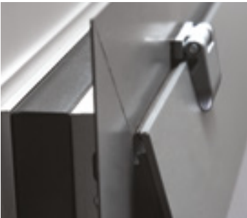
Détail rupture de pont thermique
