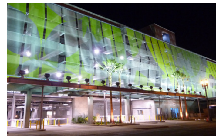
Partiell lackierte Gewebepaneele aus HAYER Architekturgewebe. Parkhaus Los Angeles Police Department, USA.
