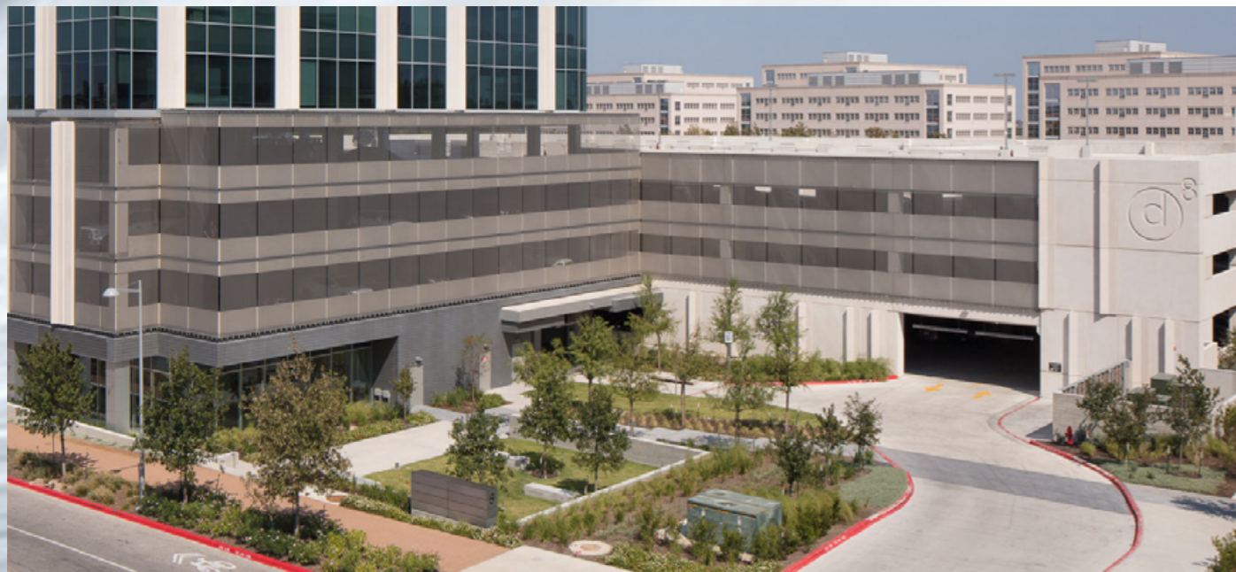
Semi-transparente Fassadenverkleidung mit HAYER Architekturgewebe. Parkhaus Domain8, Austin, USA.
