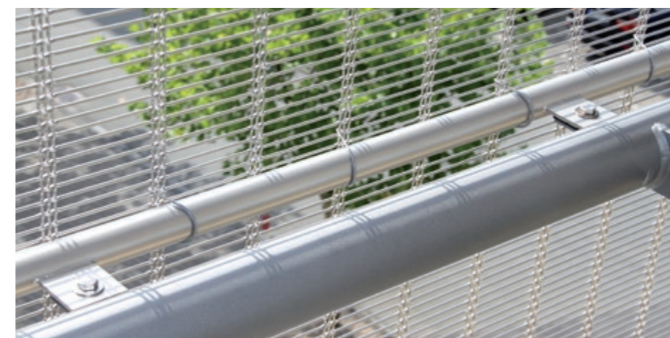
Zwischenbefestigung: Rundrohr und Drahtsicherung.
