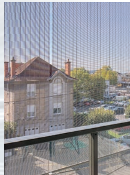
Die offene Geometrie der Architekturgewebe bewahrt die Durchsicht nach draußen. Fassadenverkleidung MULTI-BARRETTE 8123, Brive-la-Gaillarde, Frankreich.
