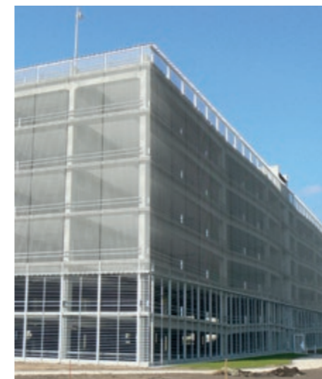
Fassadenverkleidung eines Parkhauses mit dem HAVER Architekturgewebe DOGLA-TRIO.
