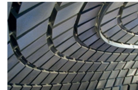
Kassettenelemente mit Akustikvlies. Print Media Academy, Heidelberg, Deutschland, DETENTION.
