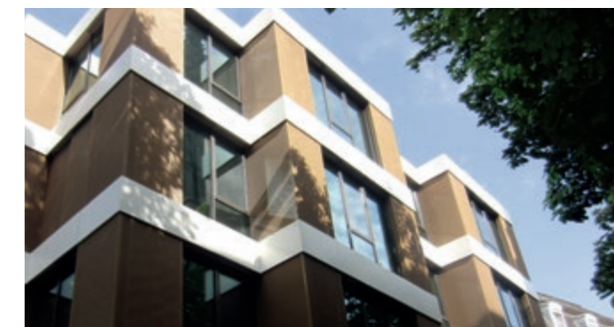
Aus Alt wird Neu. Fassadenverkleidung mit HAVER Architekturgewebe DOKAWELL-MONO 3601 am Kongresshaus Baden-Baden, Deutschland.
