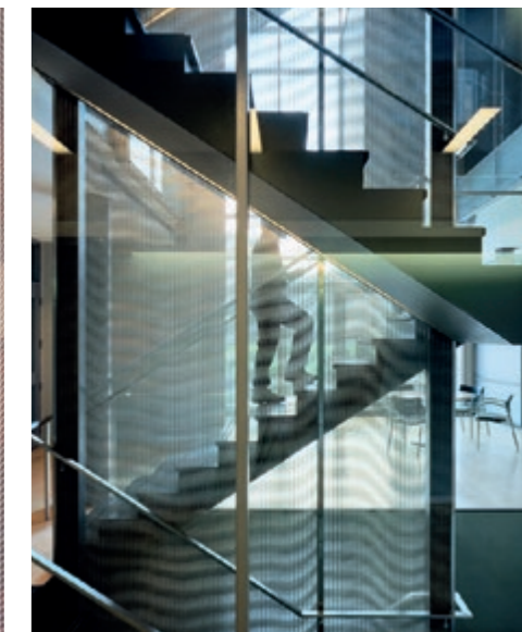
Treppenhausverkleidung erzielt mit Drahtgewebe Moiré-Effekte. McGill University, Montreal, Kanada.
