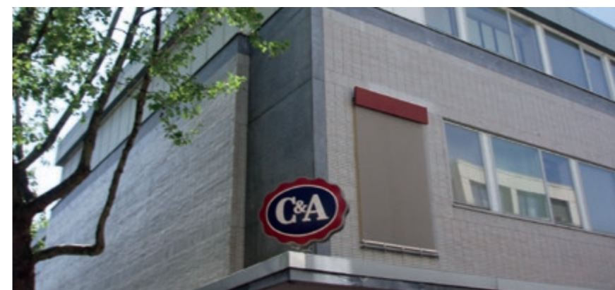
Das semi-transparentes Edstahlgewebe LARGO-NOVA 2017 verhüllt den Bestand und sorgt für natürliche Belichtung. C&A Eco Store, Mainz, Deutschland.
