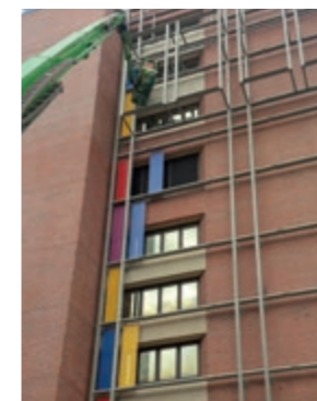
Kleine Drahtgewebe-Elemente verkleiden den alten Klinkerbau. Shands Children's Hospital, Florida, USA, LARGO-PLONUS 2022.
