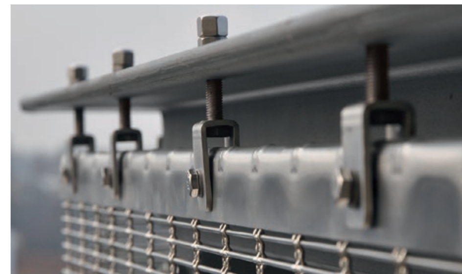
Obere Befestigung: Spannkante und Gabelschraube.
