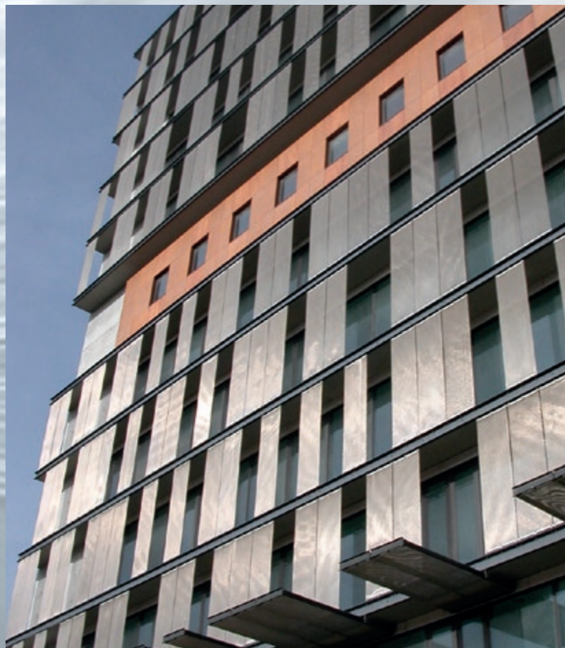
Transparente Gewebeelemente verbinden effektiven Sonnenschutz mit glänzenden Gestaltungsmöglichkeiten. Sonnenschutzfassade ECLA-MONO 4391, Lissabon, Portugal.
