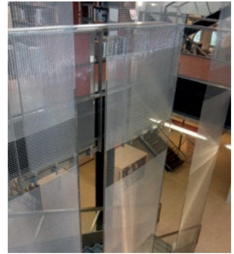
Gewebe mit wechselnden Maschenweiten. Mediathèque Chateaugiron, Frankreich.
