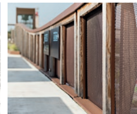
Lackierung mit braunem Strukturlack. Fußgängerbrücke Lisieux, Frankreich. DOKA-MONO 1421.
