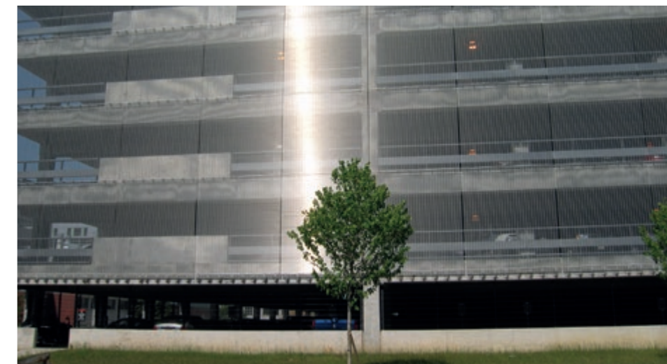
Edelstahlgewebe verleihen Fassaden im Zusammenspiel mit Sonnenschein eine elegant schimmernde Optik. Parkhausverkleidung MULTI-BARRETTE 8301, Ohio, USA.
