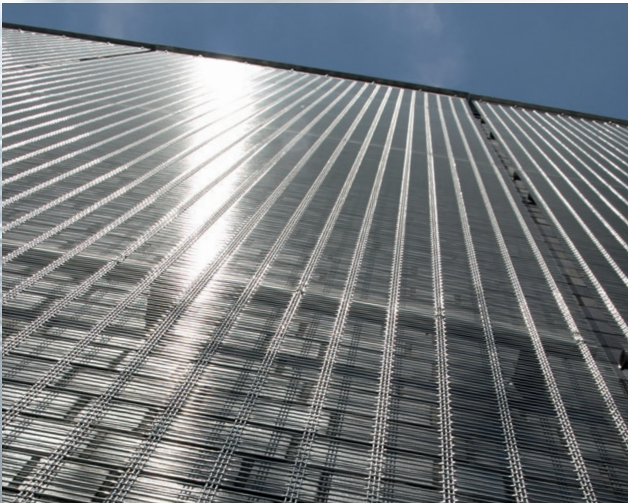
Architekturgewebe können über mehrere Geschosse hinweg vertikal gespannt werden. Tragende Unterkonstruktionen sind lediglich an der oberen und unteren Stirnseite erforderlich. Fassadenverkleidung DOGLA-TRIO 1032, Deutschland.
