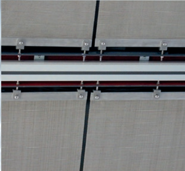
Nicht-revisionierbares Befestigungssystem für Decken mit Spannkante und Gabelschraube.
