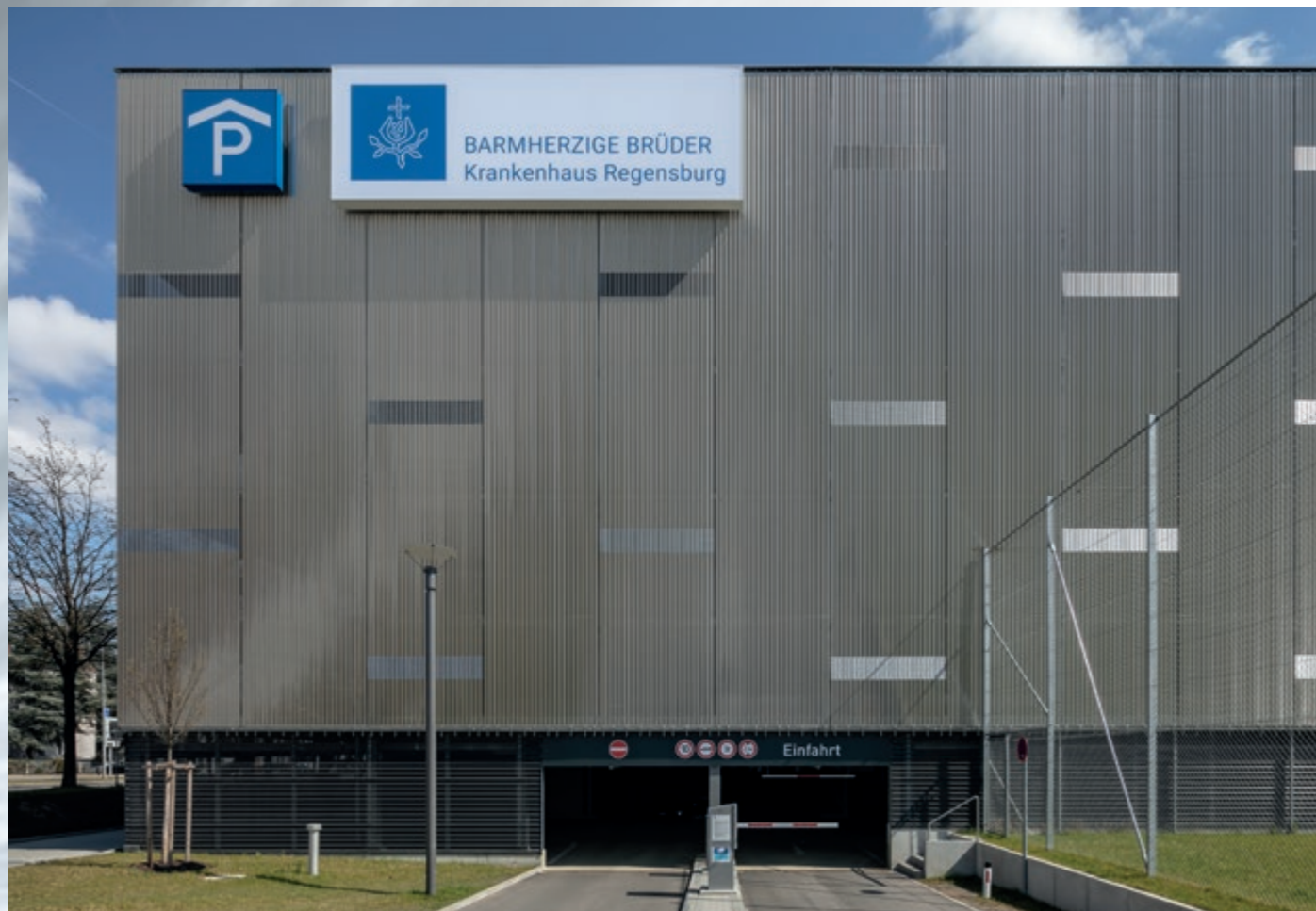
Geschlossen und dennoch transparent präsentiert sich die Parkhausverkleidung aus dem Edeltstahlgewebe LARGO-TWIST 2051. Regensburg, Deutschland.
