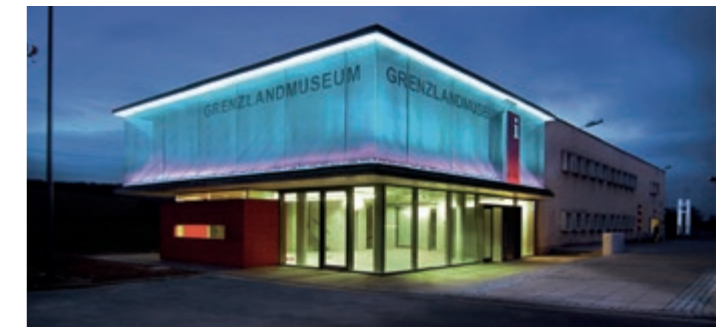
Ansicht in der Nacht mit hinterleuchtetem Drahtgewebe.
