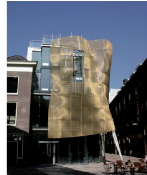
Frei geformtes Edeltstahlgewebe. De Baljurk, Den Haag, Niederlande, DOKA-MONO 1771.
