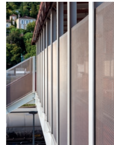
Semi-transparente Geländerfüllung. Bahnhof Agen, Frankreich, ECLA-DUO 4222.
