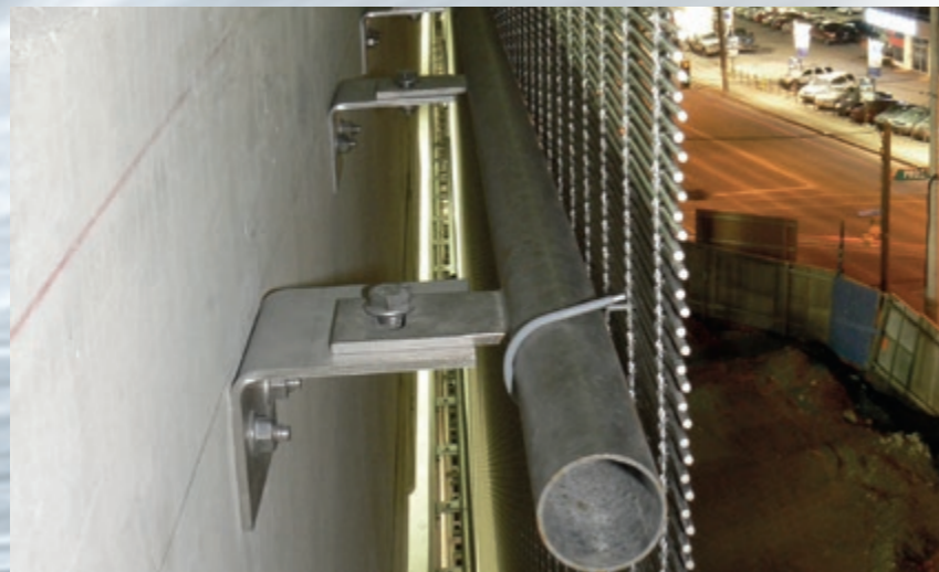
Zwischenbefestigung: Rundrohr und Drahtsicherung.
