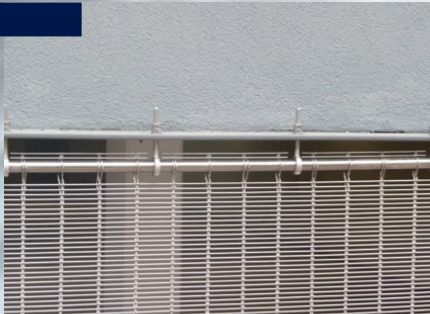
Obere Befestigung: Rundstab mit Augenschrauben.
