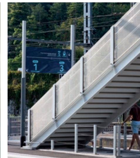
Brückenverkleidung an einem Bahnhof aus dem Edelmetallgewebe EGLA-DUO.
