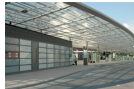
Drahtgewebe als Sonnenschutz. Busbahnhof Herne, Deutschland, DOKAWELL-MONO 8967.
