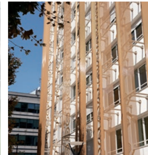
Metallic coating. Résidence Étudiante, Saint Denis, France, DOKA-MONO 1851.
