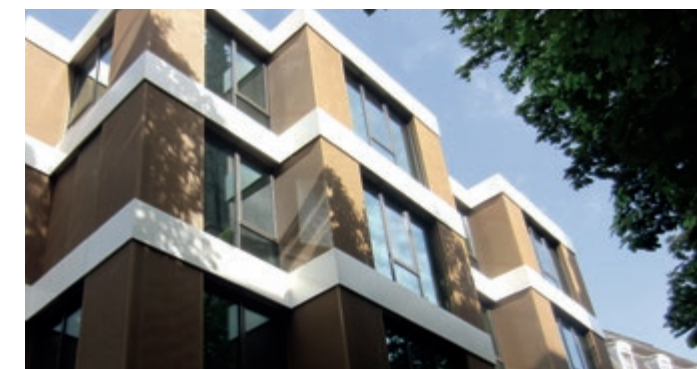
Lo antiguo se convierte en nuevo. El revestimiento de la fachada con tela para la arquitectura de HAVER DOKAWELL-MONO 3601 en el Palacio de Congresos, Baden-Baden, Alemania.
