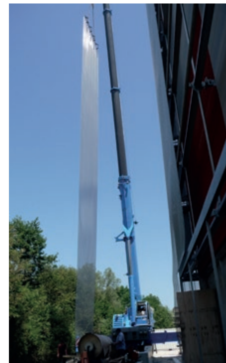
Las telas para la arquitectura se pueden tensar verticalmente pasando por encima de varias plantas. Las subestructuras sustentadoras son únicamente necesarias en la cara frontal superior e inferior.
