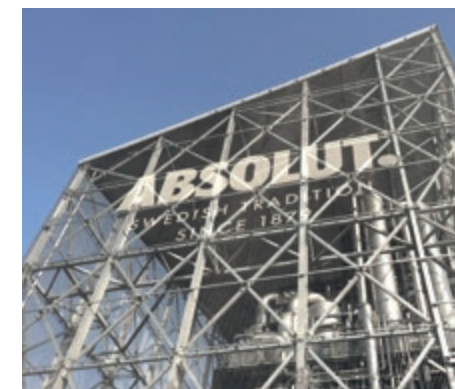
Pintura del logotipo. Cerramiento de un edificio de producción en Åhus, Suecia. TRÍO DOGLA 1032.
