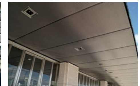
Revestimiento de techos de elementos de armazón. Estadio Krasnodar, Rusia, EGLA-MONO 5031.
