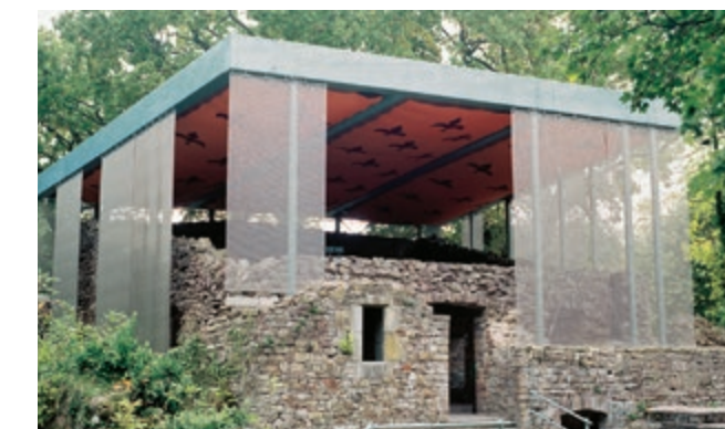
Tela de acero inoxidable semitransparente LARGO-NOVA 2017 cubre la construcción existente y proporciona una iluminación natural. C&A, Mainz, Alemania.
