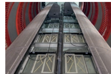
Revestimiento de la caja del ascensor con tela para arquitectura, biblioteca municipal de Ulm, Alemania.
