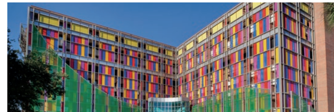
Elementos pequeños de tela metálica revisten la construcción antigua de ladrillo recocido. Shands Children's Hospital, Florida, EE. UU, LARGO-PLENUS 2022.
