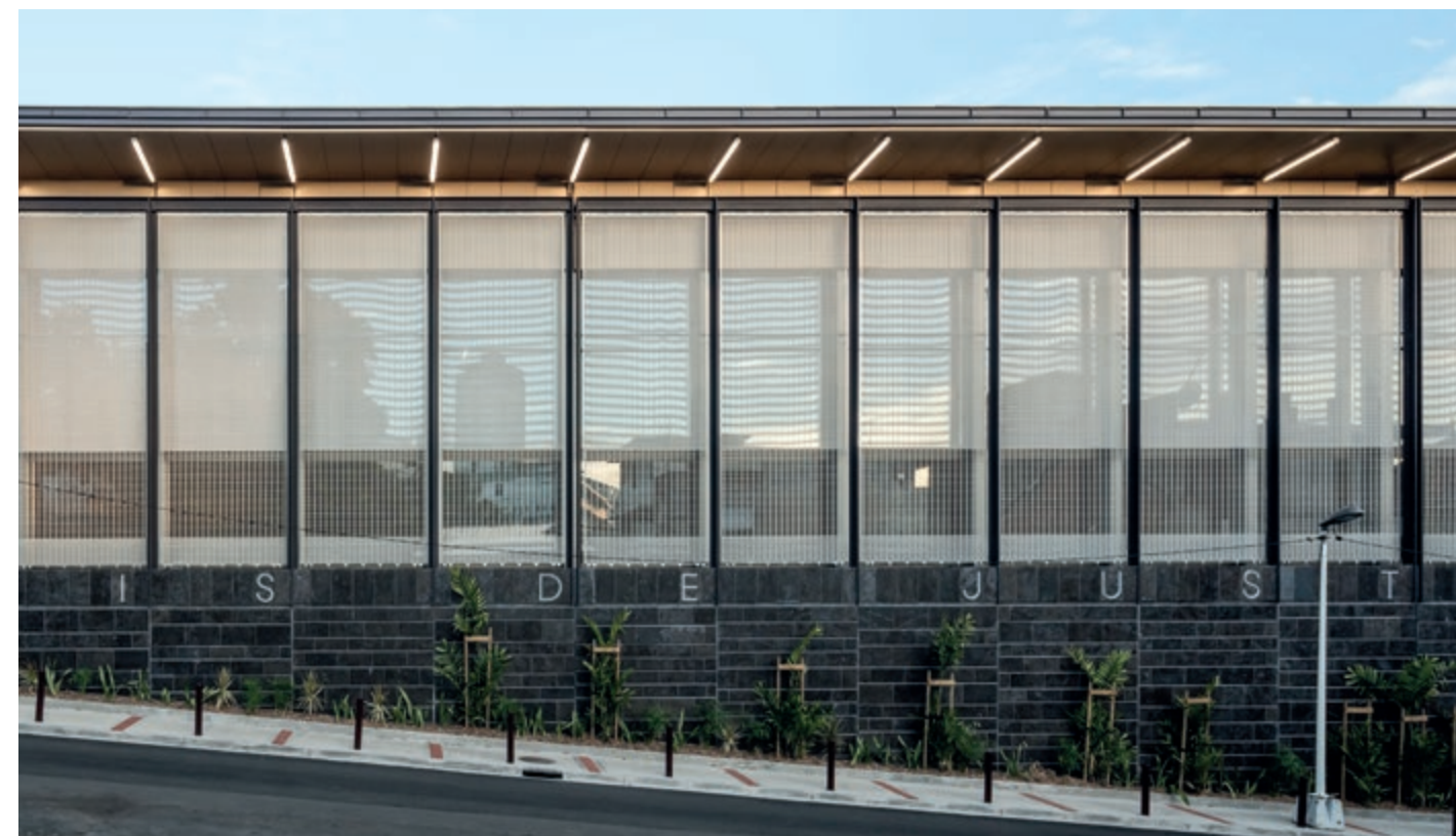
Debido a la estética purista, los tejidos de acero inoxidable LARGO-NOVA 2023 Vario, que relucen con un brillo tenue metálico en la luz de sol, subrayan el complejo arquitectónico.
