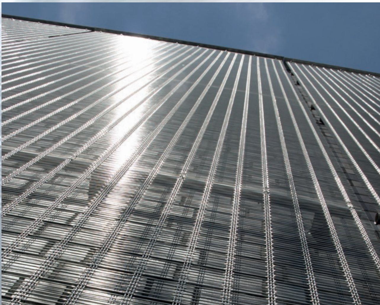
Las telas para la arquitectura se pueden tensar verticalmente pasando por encima de varias plantas. Las subestructuras sustentadoras son únicamente necesarias en la cara frontal superior e inferior. Revestimiento de fachada DOGLA-TRIO 1032, Alemania.
