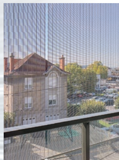
La geometría abierta de la tela para la arquitectura conserva la diafanidad hacia el exterior. Revestimiento de fachada MULTI-BARRETTE 8123, Brive-la-Gaillarde, Francia.
