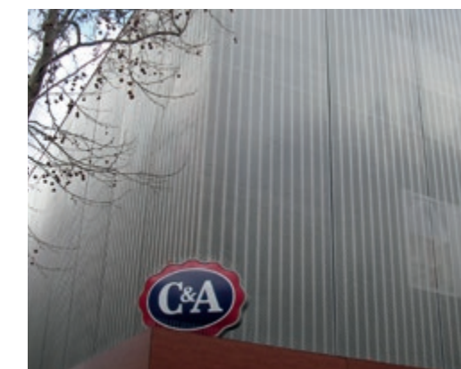
Tela de acero inoxidable semitransparente LARGO-NOVA 2017 cubre la construcción existente y proporciona una iluminación natural. C&A, Mainz, Alemania.
