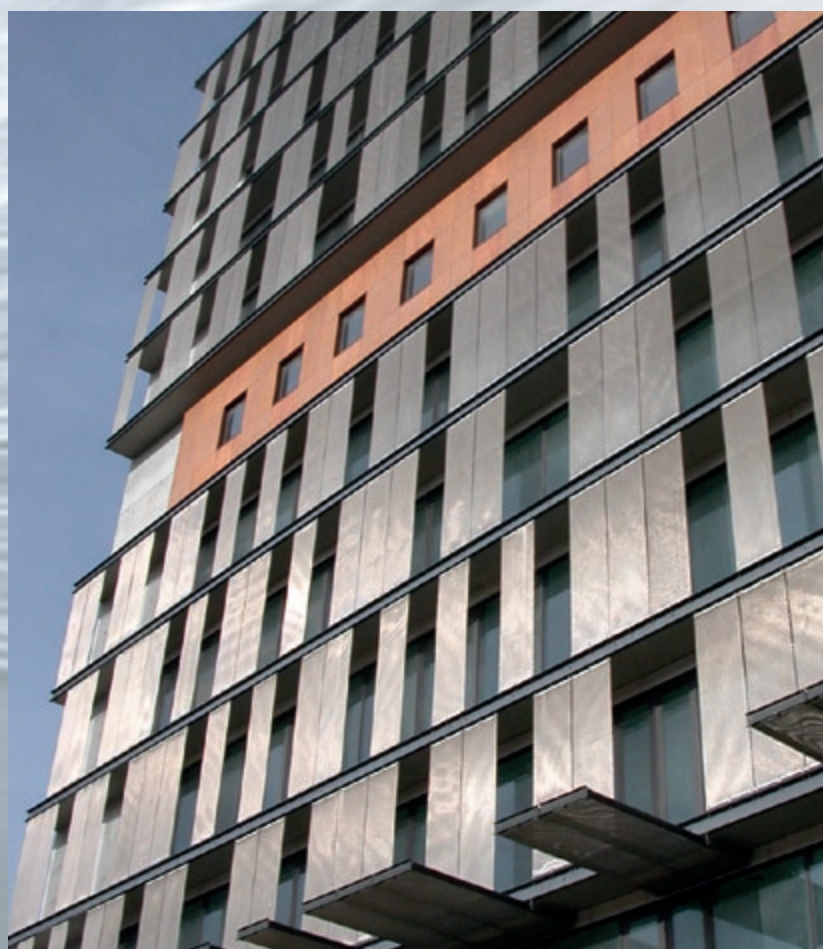
Los elementos de las telas transparentes conectan una protección solar efectiva con posibilidades de diseño reluciente. Fachada de protección solar EGLA-MONO 4391, Lisboa, Portugal.
