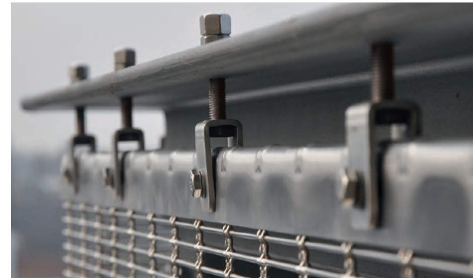
Fijación superior: pliegue tensor y tornillo de horquilla.
