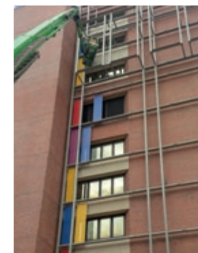
Elementos pequeños de tela metálica revisten la construcción antigua de ladrillo recocido. Shands Children's Hospital, Florida, EE. UU, LARGO-PLENUS 2022.
