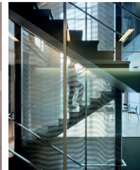
Revestimiento de escaleras logrado mediante tela metálica, efecto Moiré. Universidad de McGill, Montreal, Canadá.
