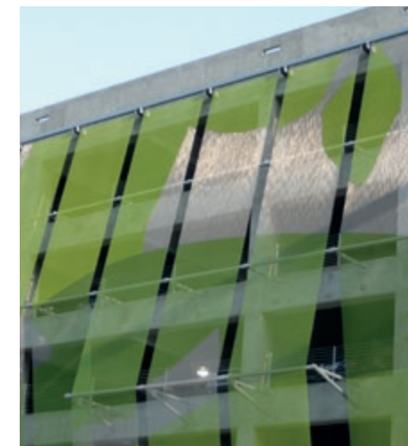
Paneles de tela parcialmente pintados. Departamento de Policía de L.A., EE.UU, EGLA-MONO 4832.
