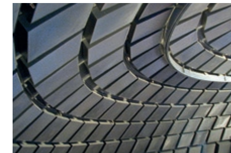
Elementos artesonados con fieltro acústico. Print Media Academy, Heidelberg, Alemania, DETENTION.
