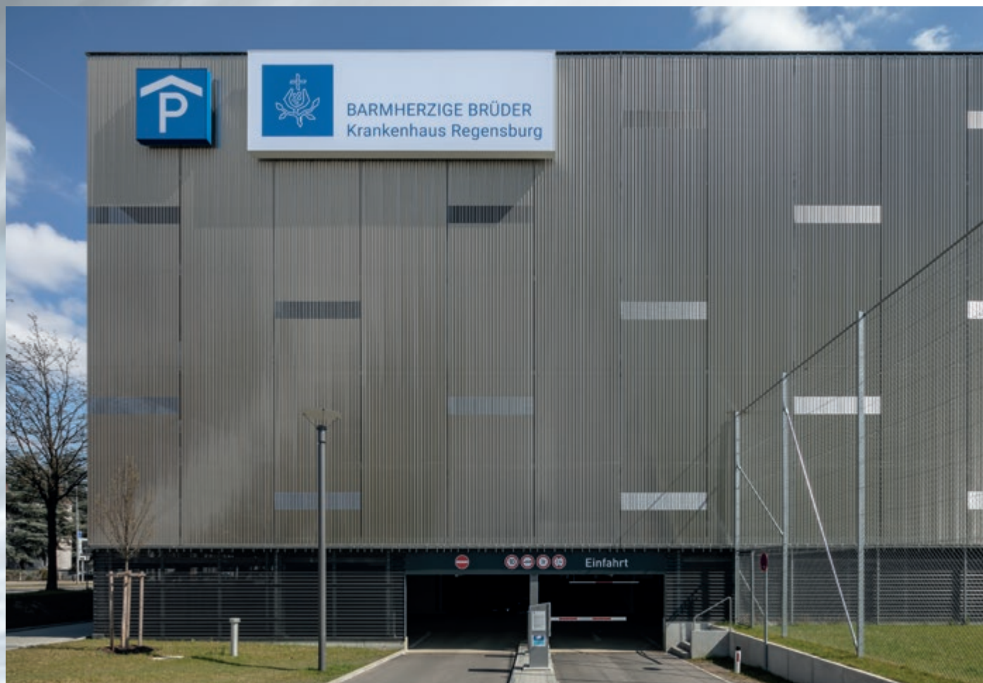
El revestimiento del aparcamiento, de malla de acero inoxidable LARGO-TWIST 2051, es cerrado y transparente a la vez. Ratisbona, Alemania.
