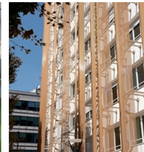
Barnizado en metálico DOKA-MONO 1851. Résidence Étudiante, Saint-Denis, Francia.
