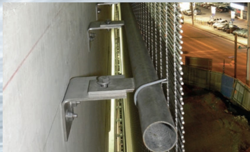
Fijación intermedia: tubo redondo y conector de alambre.
