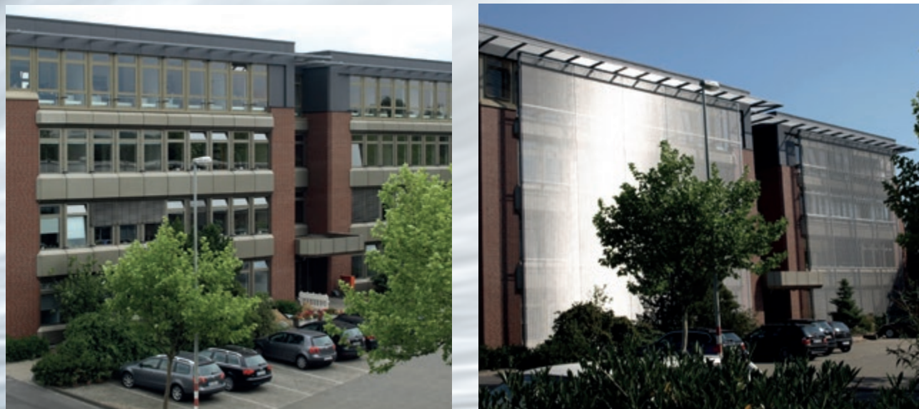
La tela metálica DOGLA-TRIO unifica visualmente la planta nueva, que se ha añadido al edificio, con la construcción antigua. Haver & Boecker, Oelde, Alemania, DOGLA-TRIO 1030.
