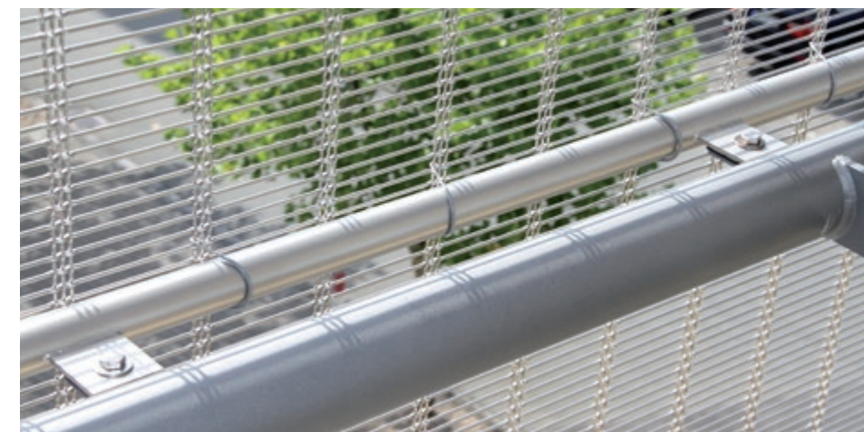
Fijación inferior: pliegue tensor, tornillo de horquilla y resorte de compresión.
