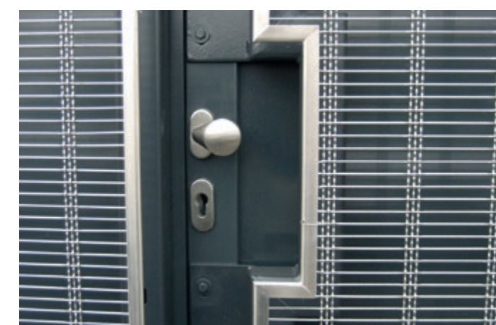
Borde de la tela con perfiles de protección del borde.
