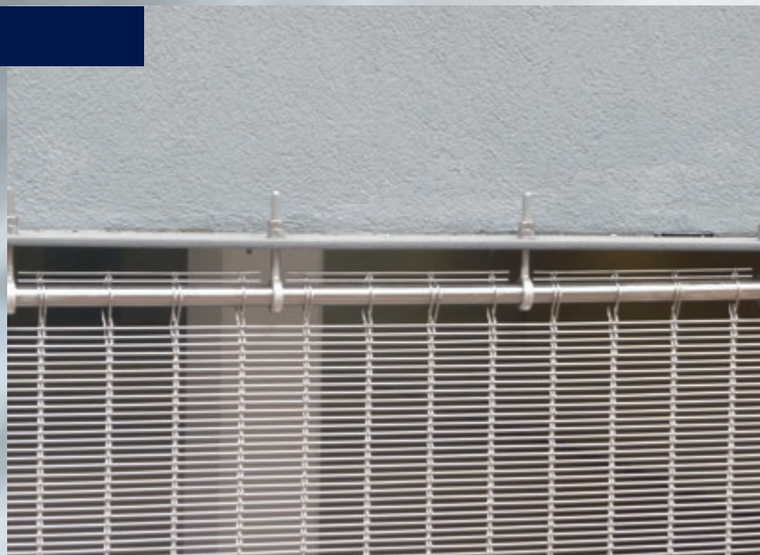
Fijación superior: barras redondas con tornillos de ojo.
