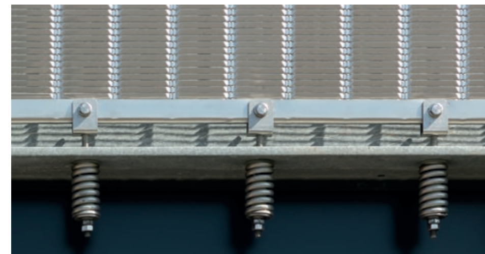
Fijación inferior: pliegue tensor, tornillo de horquilla y resorte de compresión.
