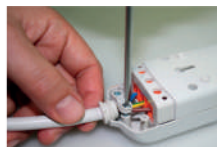
2- Connect the terminals / Fixer à la bride
