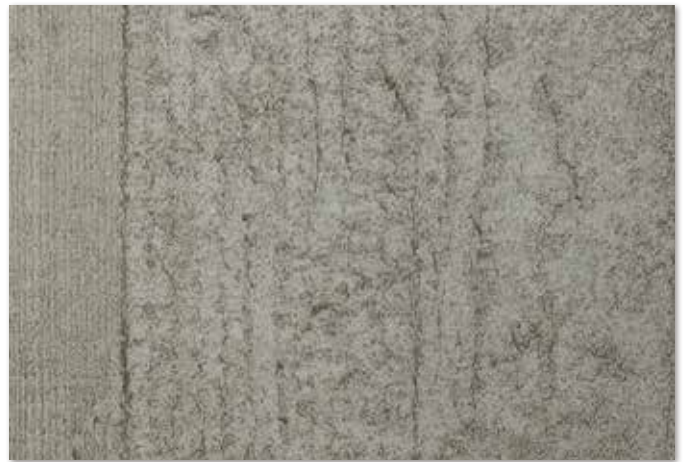
CN-2512 コンクリート(杉板型枠)
