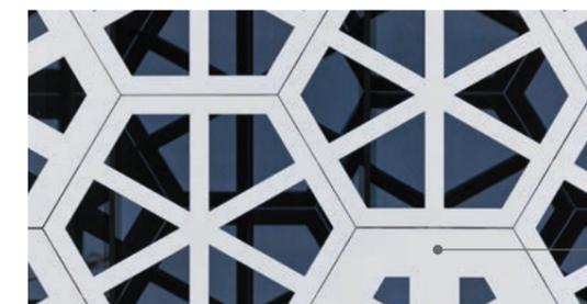
La moderna tecnologia di fresatura CNC ha consentito di progettare individualmente ciascun elemento della facciata. Il giunto di dilatazione, parte essenziale della facciata, è stato trasformato in un interessante elemento di design.
