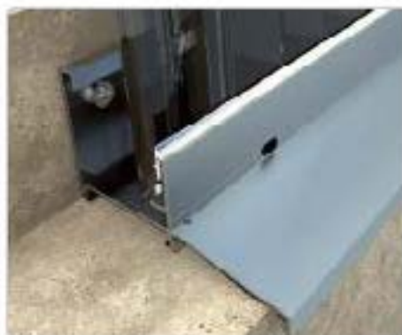
PROFILO BASE Dettaglio tamponamento verticale, inserimento su profilo di base
