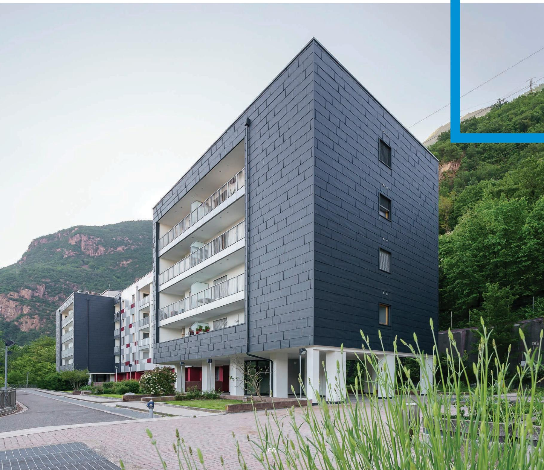
Il risanamento del complesso costituito da 2 edifici di 5 piani edificato a metà degli anni '90 con struttura a telaio in calcestruzzo armato e solai di interpiano con struttura tipo predalles.
