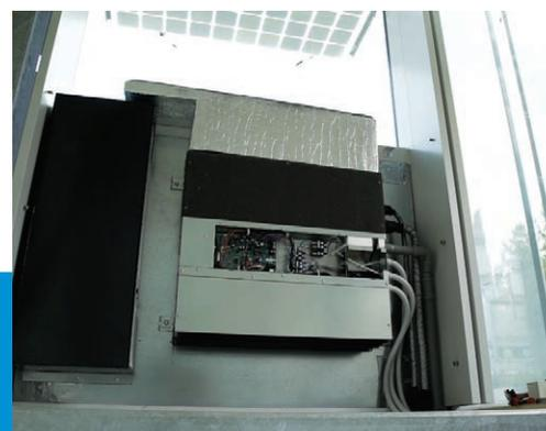
Con il nostro ufficio ricerca e sviluppo abbiamo studiato una soluzione di ventilazione ad hoc, in grado di adattarsi alle esigenze progettuali del modulo per sfruttare al meglio gli spazi e le prese d'aria disponibili. In particolare, in seguito ad uno studio dei componenti interni, abbiamo ingegnerizzato la parte di espulsione dell'aria viziata e di aspirazione di aria esterna al modulo al fine di garantire una corretta filtrazione e ricambio d'aria.
