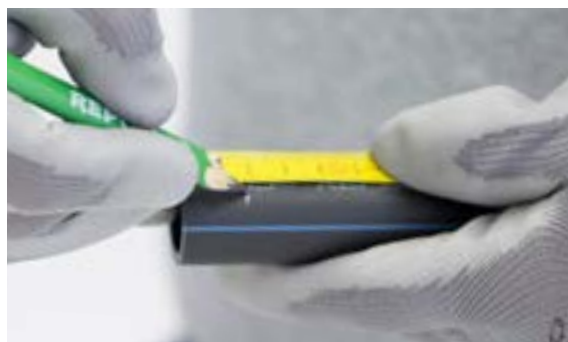
Marcar en el tubo la longitud medida
