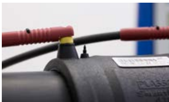
Esperar a que termine el proceso de soldadura (salida de los testigos)
