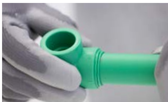
Introducir el tubo en el accesorio
