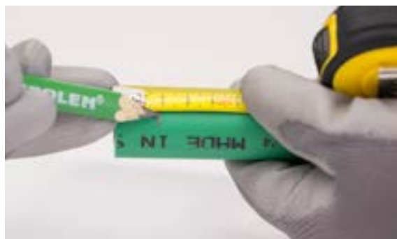
Marcar en el tubo la longitud medida
