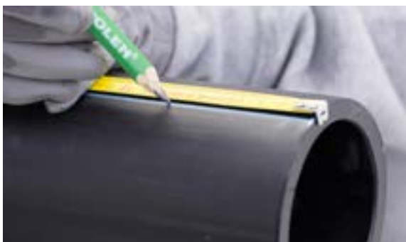
Marcar en el tubo la longitud medida
