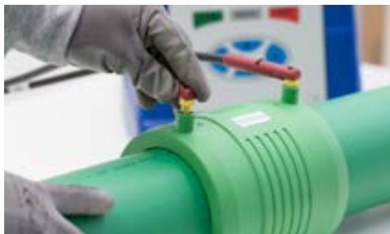
Conectar los bornes de la máquina al accesorio
