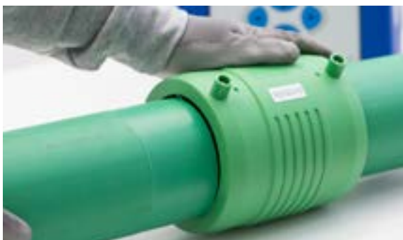
Introducir el tubo en el accesorio sin forzarlo (el tubo debe entrar sin forzarlo pero sin holgura).
