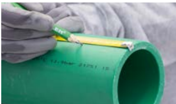
Marcar en el tubo la longitud medida
