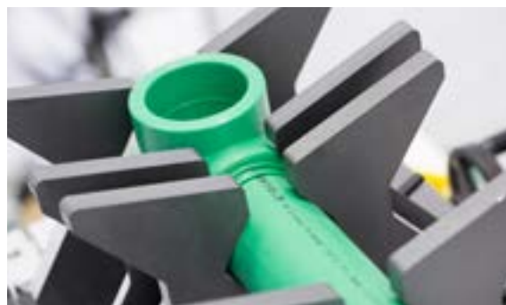
Introducir el tubo en el accesorio
