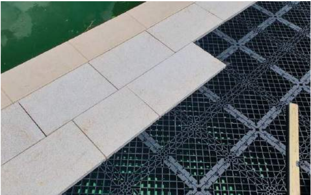
Villa privata – Bordo piscina Tribunj, Croazia GRF System – Eterno SE
