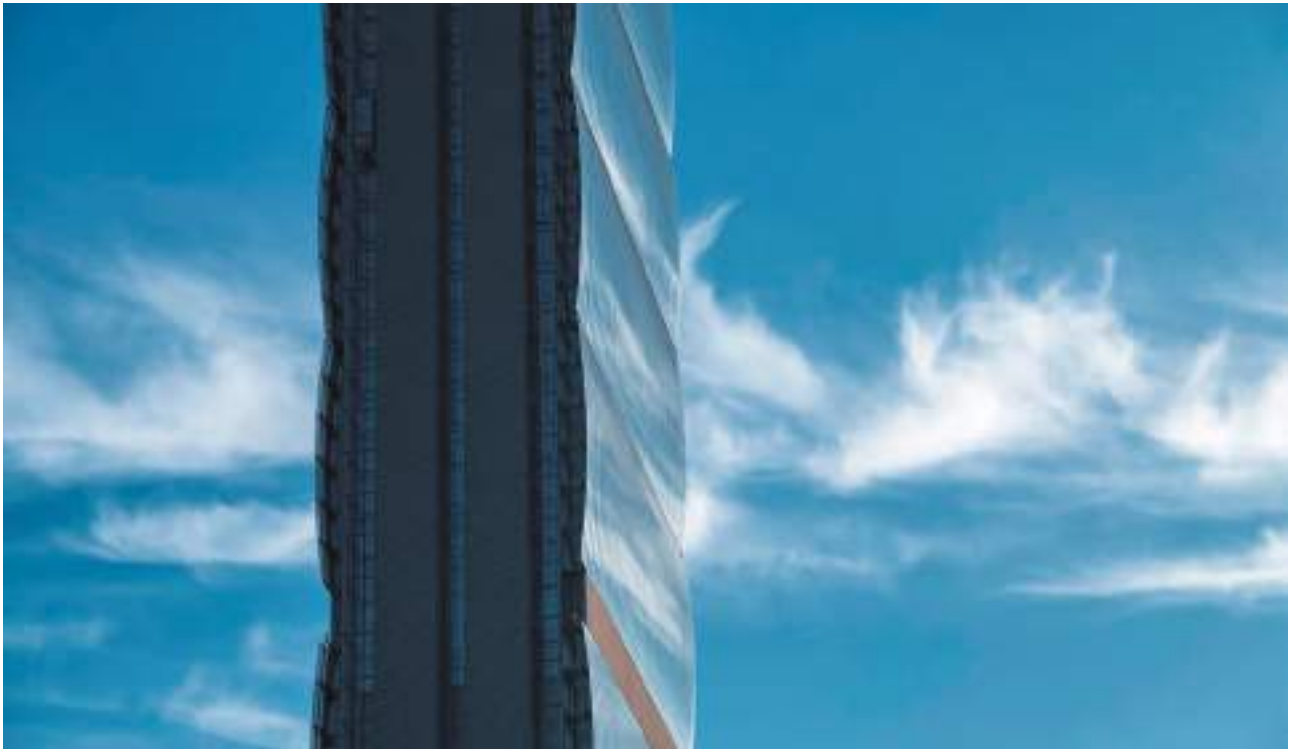
Torre Allianz - Rooftop, terrazze e aree esterne Milano, Italia Pedestal System - Eterno SE
