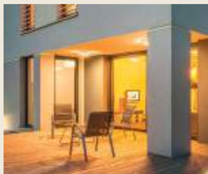
Abitazioni prefabbricate in legno Prefabricated homes Wood
