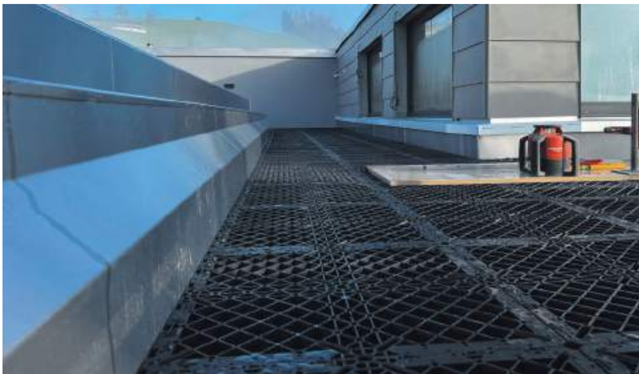
Villa privata – Rooftop, terrazze e aree esterne Svizzera Pedestal System – Pedestal Prime® con GRF System
