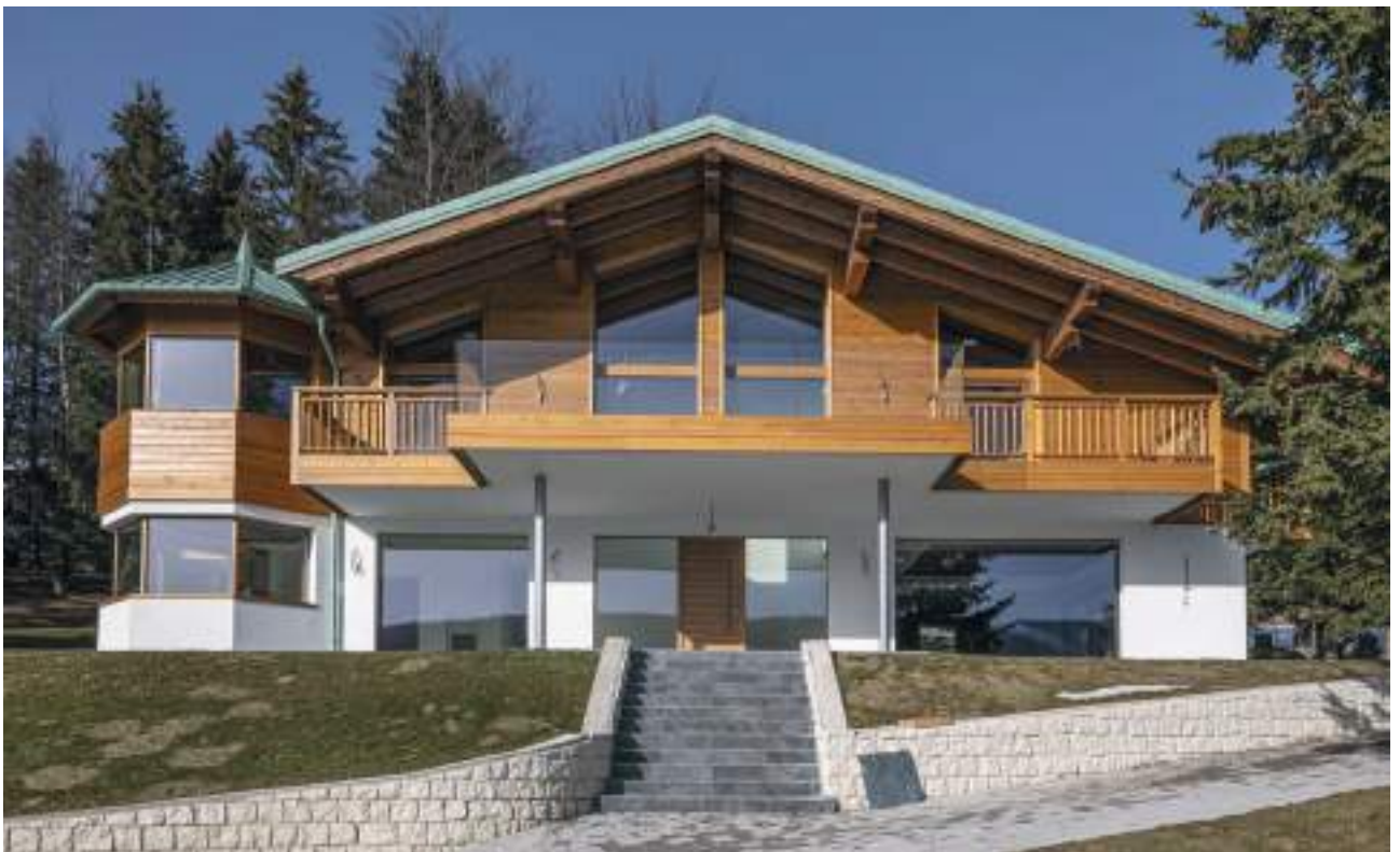
Villa privata – Rooftop, terrazze e aree esterne Folgaria (TN), Italia Pedestal System – Eterno SE e Star.T
