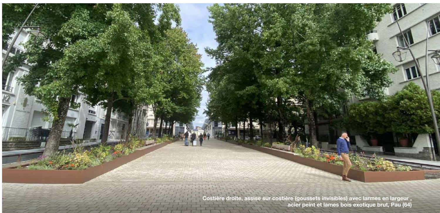
Costières droites, assise sur costière (goussets invisibles) avec lames en largeur, acier corten sablé activé et lames bois exotique brut, Lucé (28)
