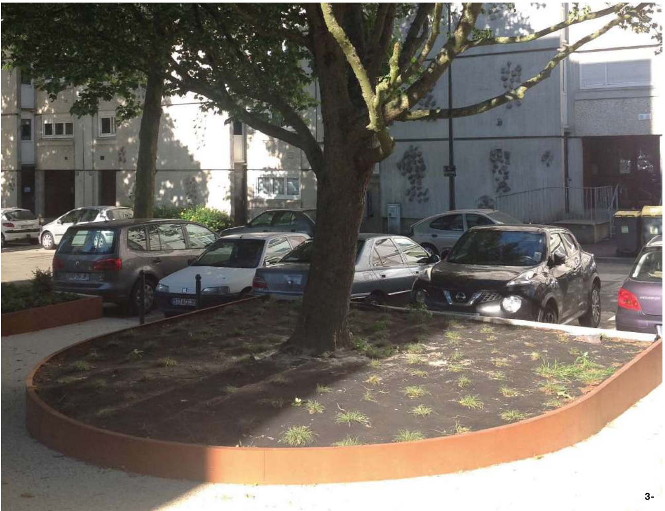
1- Pontoise (95) | Acier corten sablé et activé | Bac sans fond panneaué sur mesure - Sanded and activated corten steel | Specific planter without bottom • 2- Cergy (95) | Acier corten sablé et activé | Bordure sur mesure avec découpe laser - Sanded and activated corten steel | Specific edging with laser cut • 3- Rennes (35) | Acier corten sablé, activé et stabilisé naturellement | Bac sans fond sur mesure - Sanded, activated and naturally stabilized corten steel | Specific planter without basis
