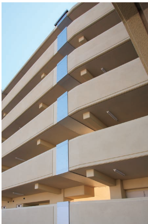
大阪府営住宅
