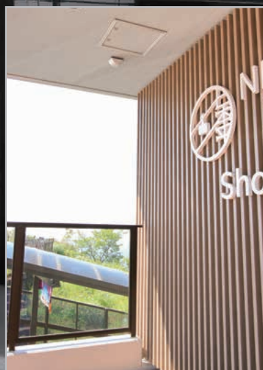
天井点検口／RC型 日本平ロープウェイ駅（静岡県）
