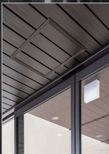
天井点検口／RC型 某物件（鹿児島県）
