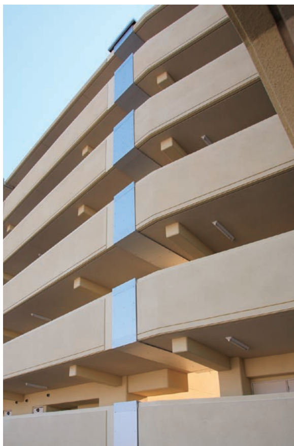
大阪府営住宅
