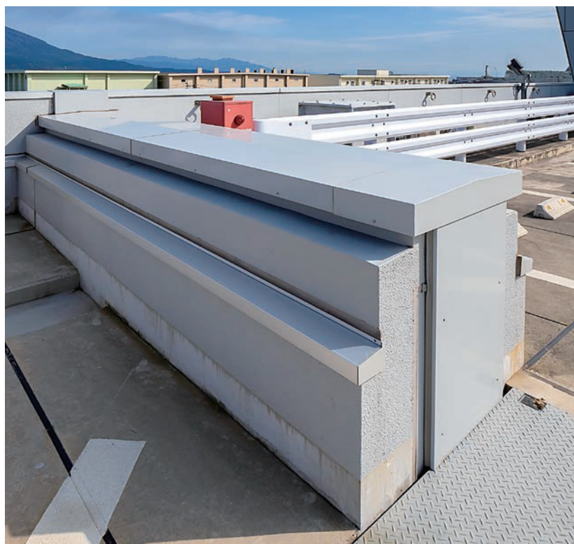
屋上 1工区、2工区との接続部
