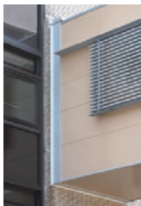
庁舎・役場 外壁
