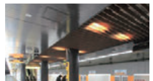
駅舎・空港建築 点検口
