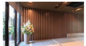
集合住宅 内外装ルーバー
