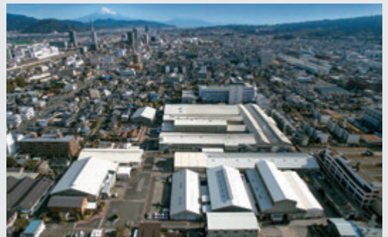
静岡本社・工場の見学も随時受け付けております。
