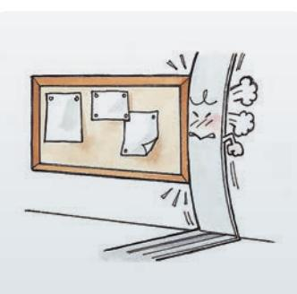
エキスパンション・ジョイント・カバーは動くのが正常な状態です。動かないように、他の材料で固定したりすることは、絶対にしないでください。脱落したり変形する恐れがあります。
