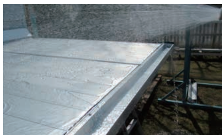
散水試験の様子
