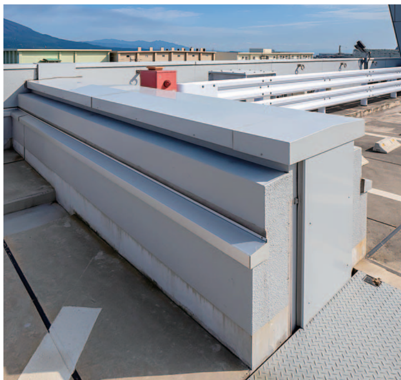
屋上 1工区、2工区との接続部
