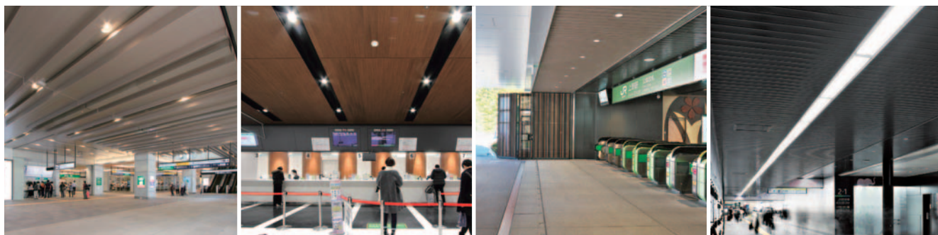
JR新宿駅・バスタ新宿 (新宿基盤整備上部仕上工事他)
