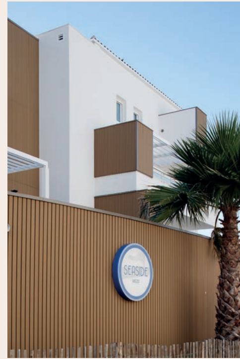
Logement collectif - Mèze (34) - COVER 6 - Teinte Sun Architecte : ARM Roch Marques
