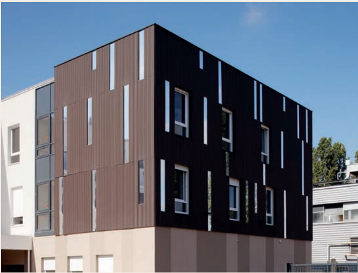
EHPAD - Saint Julien en Genevois (74) - COVER 6 - Teinte Earth Architecte : Chabanne
