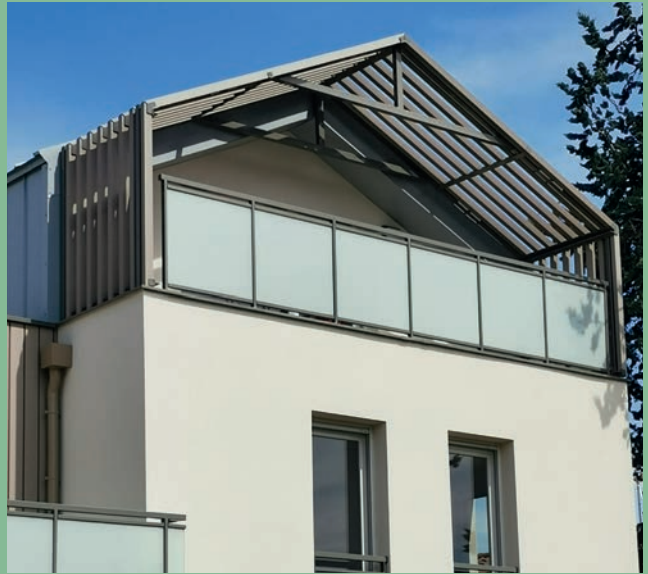
SPACE 6 - Teinte Sand • Architecte : Anne Terrier / Ann'T Architecture
