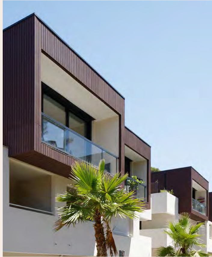
Mehrfamilienhaus - Quinta Coliba - Marseille (13) - SMART 9 - Farbton Heat Architekt: MAP Architecture
