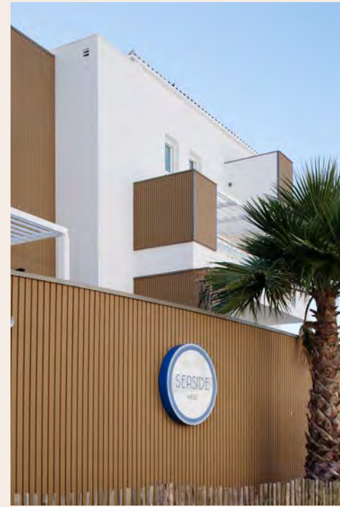
Mehrfamilienhaus - Méze (34) - COVER 6 - Farbton Sun Architekt: ARM Roch Marques
