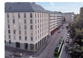
Helsingin Kallion Kaarle Property type: Residential Developer: Rakennusliike Lapti Oy Number of residences: 43
