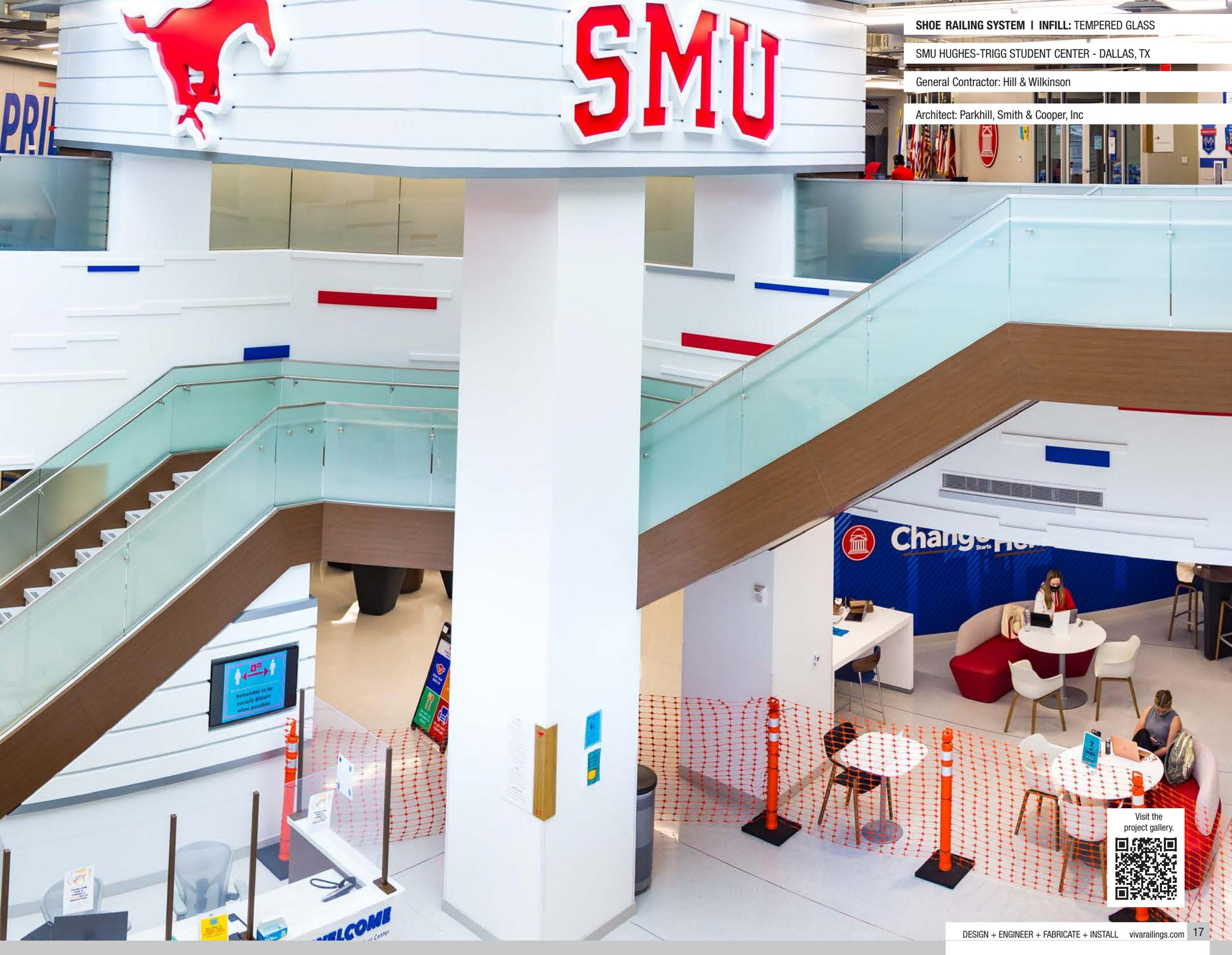
SHOE RAILING SYSTEM | INFILL: TEMPERED GLASS
