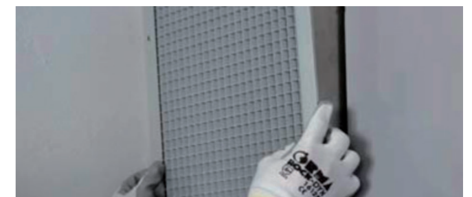
22 Inserimento griglia di aerazione
