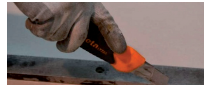
18 Taglio del pannello REI Pannel
