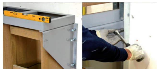
15 Scarico pesi a muro
