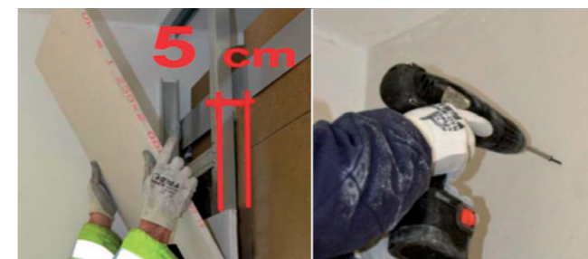
19 Fissaggio pannello
