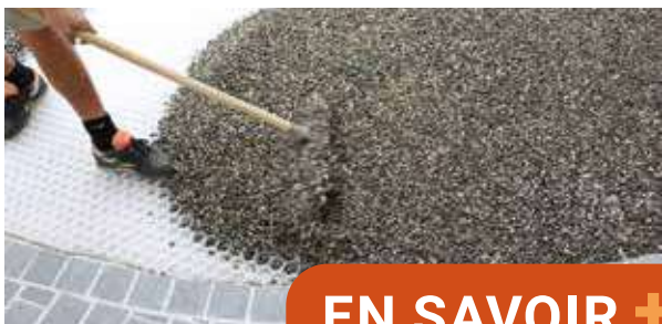
Remplissage et finition. Gravier concassé de granulométrie comprise entre 5 (mini.) et 10 (maxi.).
