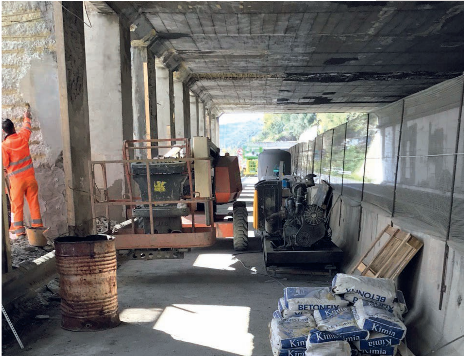
GALLERIA ARTIFICIALE_AUTOSTRADA MESSINA-CATANIA
