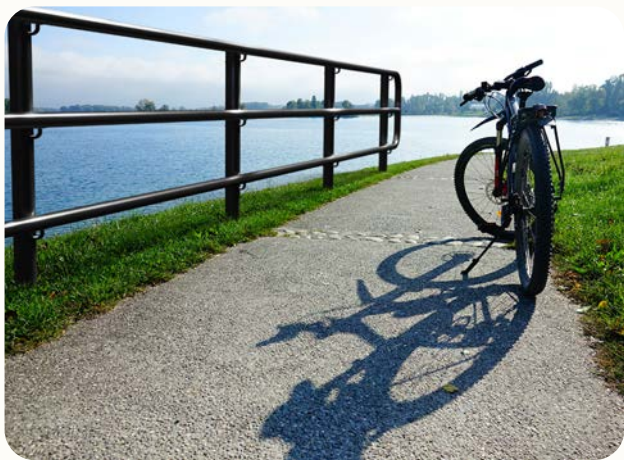
En avslutning på ett GC-räcke utformad för att vara säker för gång- och cykeltrafikanter. (Bild: MAXA)
