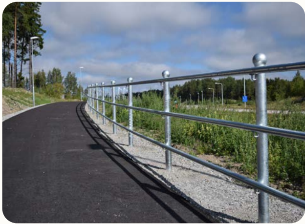
GC-räcke vid lutande slänt. (Bild: FLEXI GC)
