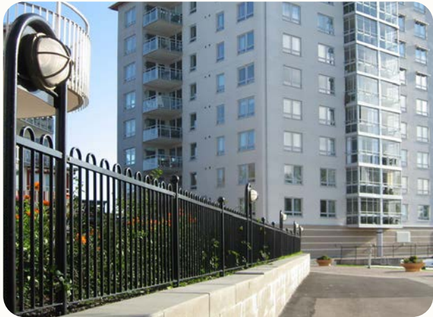
Ett räcke kombinerat med stenmur tar upp höjdskillnader, avgränsar, skyddar rabatten och ger samtidigt en integrerad belysning av området. (Bild: VÅGMÄSTAREN)
