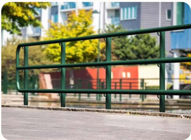
Ett GC-räckes vertikala delar har ett internt avstånd på maximalt 0,45 m för att förhindra fall genom räcket. (Bild: MAXA)
