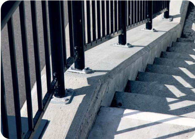
Kombination av standard golfundament och specialtillverkade vinklade golfundament för lutande underlag. (Bild: OPTI spjälmodul)
