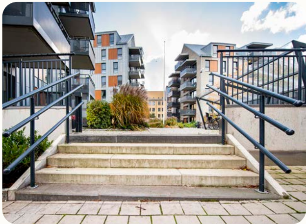
Trappor och ramper på en tomt ska ha balansstöd i form av ledstång, om det behövs för att skydda mot fall. (Bild: OPTI, OPTI spjälmodul)
