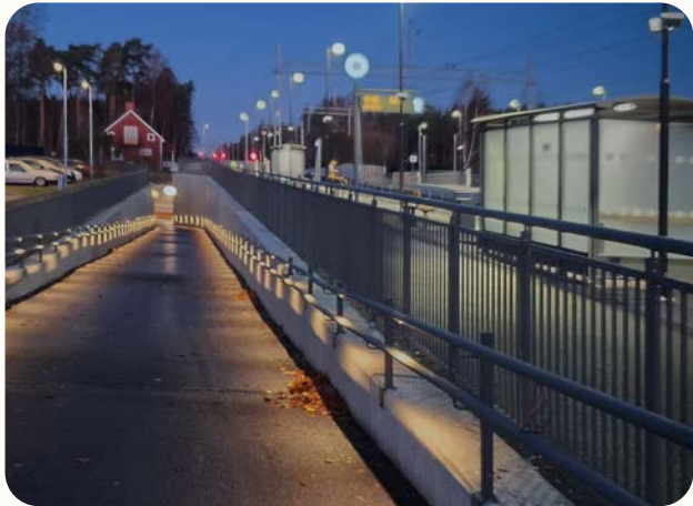
Integrerad räckesbelysning är ett vanligt önskemål i områden kring resecentrum, där människor rör sig under de flesta av dygnets timmar. (Bild: FLEXI, OPTI spjälmodul)
