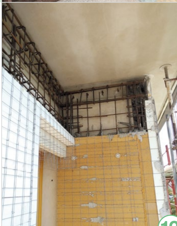
10 Pannello con calcestruzzo spruzzato per applicazione interna
