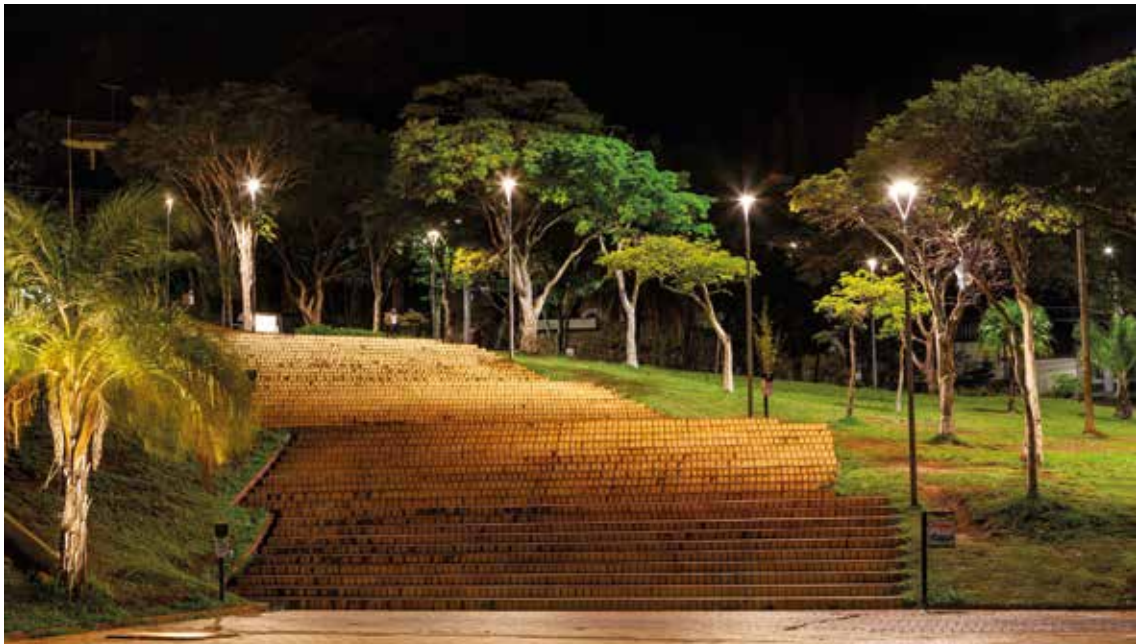
Luminarias Simon que proporcionan luz de alta calidad reduciendo la contaminación lumínica y el consumo de energía.
