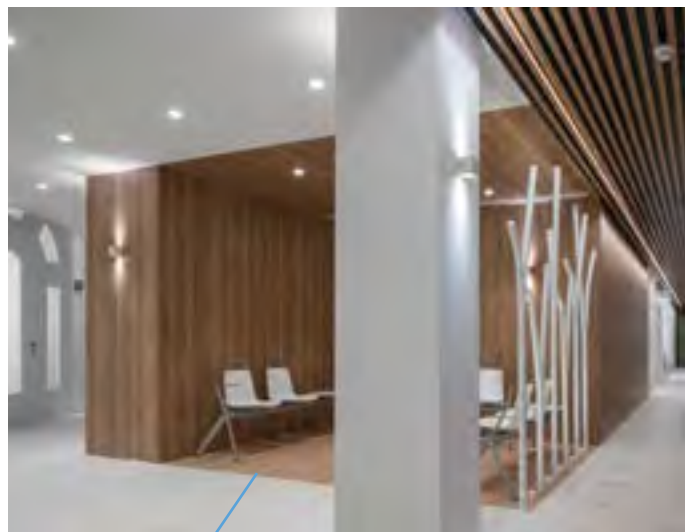
LUMINÁRIAS DE PAREDE E DE TETO
