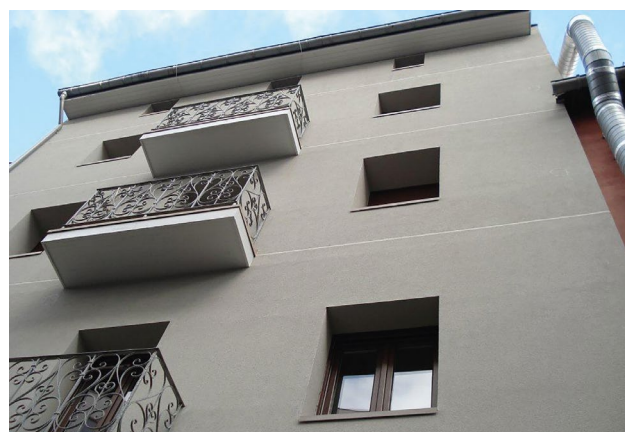
Rehabilitación de edificio con Placotherm V
