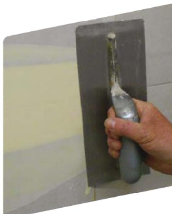
Las placas deberán instalarse con los bordes afinados pegados y con los bordes cuadrados a una distancia de 2-3 mm, para que la pasta de juntas pueda penetrar en dicho espacio y garantizar la completa protección del sistema.
