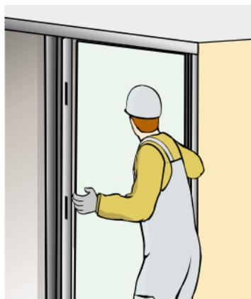
Para sujetar la placa **Coreboard®** insertaremos los perfiles de fijación uno en cada montante, entre éste y la placa.
