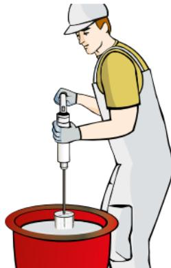
Se mezclará a mano energicamente hasta obtener la consistencia adecuada, si el mezclado es mecánico por medio de un batidor rotatorio este no sobrepasará las 380 rpm.
