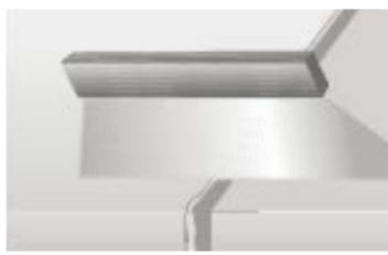
Para un acabado liso, aplicar una ultima capa de alisado con Pasta **Placo® PR Multi**, con un ancho superior al de la junta.
