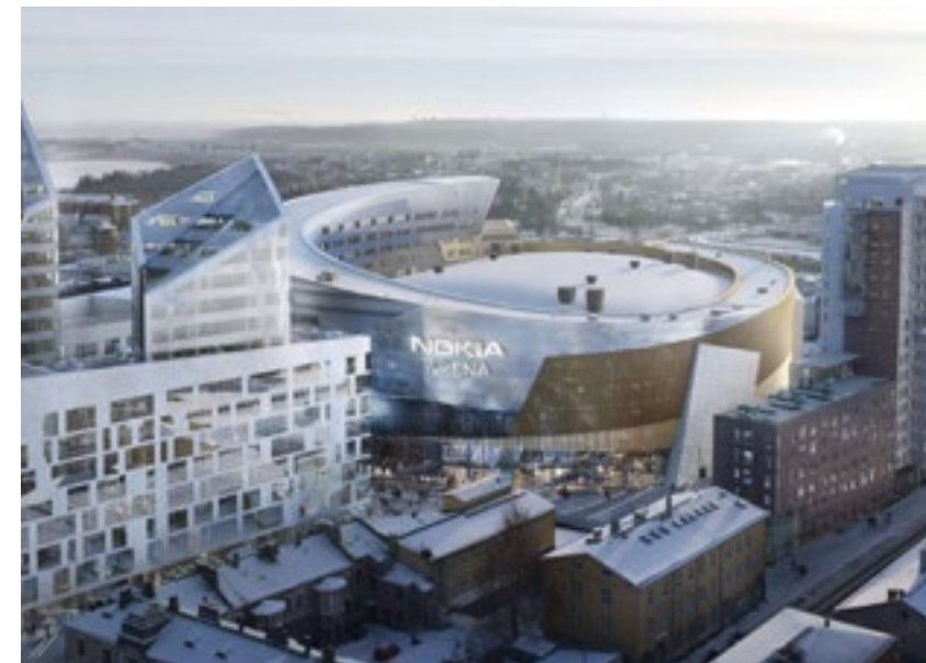
Nokia Arena, Lapland Hotel & Casino Property type: Nokia Arena, Lapland Hotel & Casino Developer: SRV Yhtiöt Oyj Number of residences: 148/105
