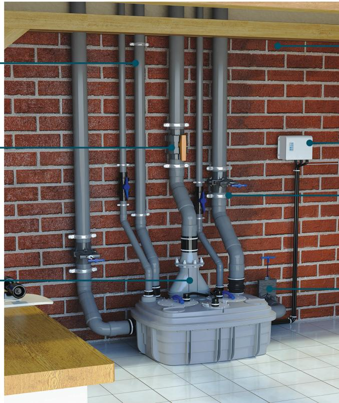
Installation hors-gel, dans un local éclairé et de dimensions suffisantes pour effectuer la maintenance
