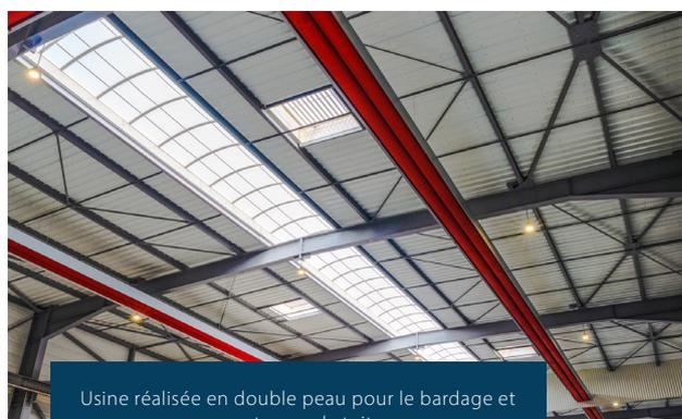
Usine réalisée en double peau pour le bardage et supports pour la toiture.
