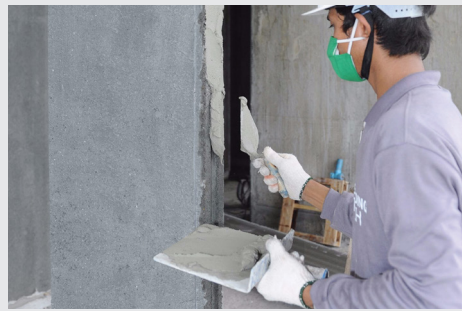
6. ทากาวประสานแผ่นคอนกรีตบริเวณด้านข้าง แผ่น เพื่อติดตั้งแผ่นต่อไป ซึ่งช่วยลดการเกิด รอยร้าวระหว่างรอยต่อได้อย่างมีประสิทธิภาพ
