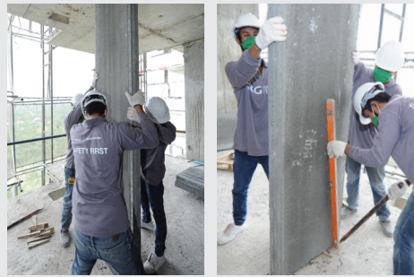
4. ใช้คนงานน้อย ในการติดตั้งแผ่น โดยเช็คระยะ แนวตั้งและแนวราบ และตอกลิ่มด้านล่างเพื่อ ยกแผ่นปรับระดับ จากนั้นจะตอกลิ่มด้านบน และปรับแผ่นให้ได้ระนาบ
