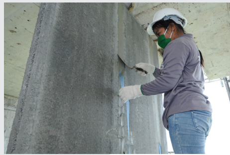
8. เก็บรอยต่อระหว่างแผ่นด้วยตาข่ายใยแก้ว และกาวประสานแผ่นคอนกรีต เพื่อช่วยลด รอยร้าวระหว่างรอยต่อได้อย่างมีประสิทธิภาพ
