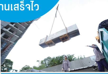
1. ขนส่งแผ่นคอนกรีตมวลเบาสำเร็จรูป ที่หน้างานด้วย Tower Crane / Mobile Crane
