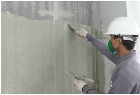
11. เก็บงานด้วยปูนฉาบแต่งผิวชนิดบาง (skim coat) งานฉาบง่าย สะดวก รวดเร็ว ผนังงานไม่เลอะเทอะ
