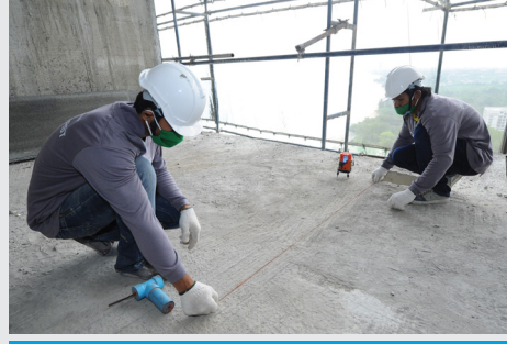
2. กำหนดตำแหน่งติดตั้ง โดยตั้งไลน์เพื่อวางแนว ในการติดตั้งผนัง
