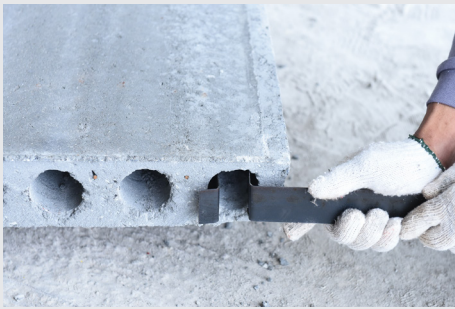
3. ใส่เพลทเหล็กด้วยที่ช่องสุดท้ายของแผ่นซึ่งเป็น อุปกรณ์ที่ช่วยให้ยึดแผ่นได้แน่นหนาแข็งแรง
