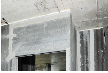
9. สะดวก ง่าย ไม่ต้องมีการตั้งแบบเพื่อหล่อเสาเอ็นและคานทับหลัง สามารถติดตั้งแผ่นเสมือนทับหลังได้เลย
