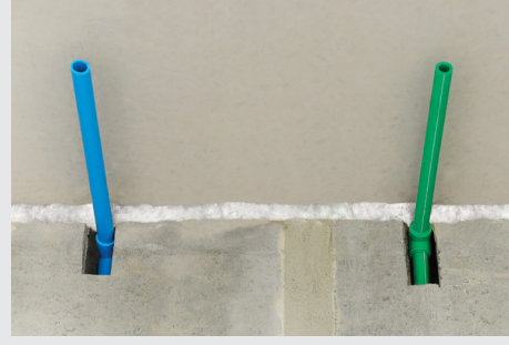
10. งานเจาะฝังท่อระบบ สามารถร้อยท่อสายไฟ และท่อประปาผ่านช่องภายในแผ่นได้เลย สะดวก ง่าย และรวดเร็ว ไม่ต้องสกัดผนังเป็นแนวยาว
