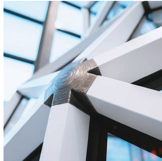
VISS 3 3D nœuds en acier imprimés
