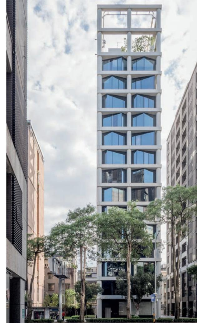
Il contrasto tra la rigida struttura antisismica in cemento armato e le superfici interne in vetro filigranato minimali è uno degli aspetti fondamentali del progetto Futura One di Taipei. Il sistema in acciaio Jansen permette la realizzazione di costruzioni senza telaio, con ampie superfici vetrate in grado di resistere ai carichi di vento tipici dei tifoni regionali. Questo lo rende la scelta ideale per questo progetto.
