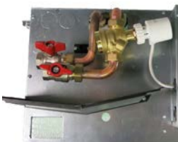
D2B2+DT Druckunabhängige Regelventile und Absperrventile
