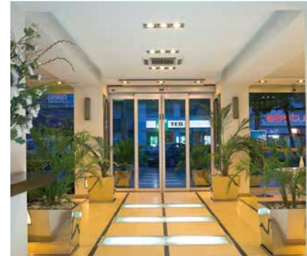
La porte fonctionne en mode normal (coulissante et automatique). En cas d'urgence, les vantaux se rabattent par une simple poussée de la main vers l'extérieur et se replient sur les côtés pour laisser libre un large passage d'évacuation.
