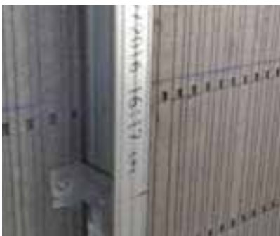
Fissaggio delle lastre in cartongesso.
