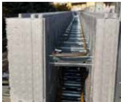
Alloggiamento delle barre orizzontali.
