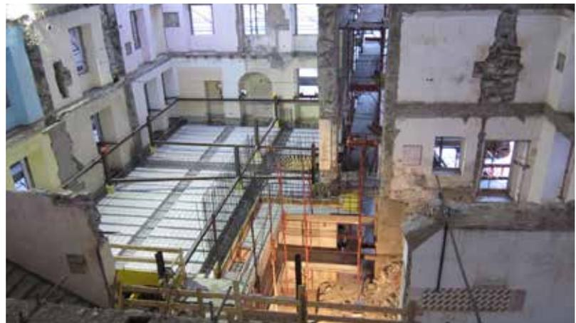
Sostituzione di vecchi solai con Termosolaio per la riqualificazione statica ed energetica
