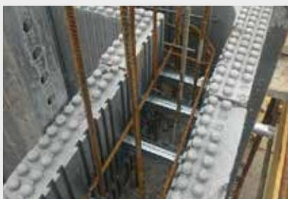
**5** Completare il perimetro fino a chiusura del primo corso. Disporre le armature orizzontali negli alloggiamenti del distanziale.
