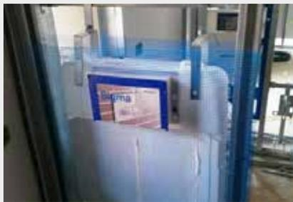
**5** Nei bagni e cucine disporre appositi sostegni per i relativi attacchi idraulici o sanitari sospesi. Le lastre sono facilmente sagomabili.
