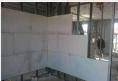
**10** Proseguire con la posa delle lastre superiori sfalsando i giunti. Procedere al taglio della lastra con cutter, incidendo due/più volte.
