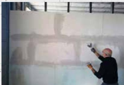
**11** Dopo un'ora, asportare la colla in eccesso e stuccare giunti e viti. Passare la seconda mano di stuccatura con il **collante PT**.
