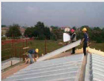
**4** Posizionare i singoli pannelli come da schema di posa concordato. Una volta posizionati sono subito pedonabili in tutta sicurezza.
