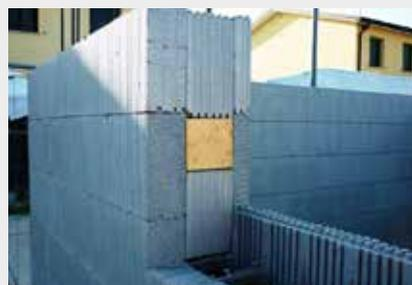
**6** Utilizzare gli *Inserti in EPS/Legno* a creazione della spalletta delle aperture inserendoli dall'alto nella fessura a coda di rondine.
