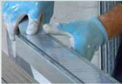
**2** Fissare i **profili a "U"** a terra seguendo il tracciato. Incollare sul dorso delle stesse la **guarnizione** mono o biadesiva antirumore.
