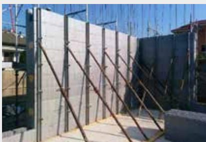
**8** Raggiunta l'altezza di piano, utilizzare l'attrezzatura per la messa a piombo della parete. I puntelli sono posti ogni 80 cm e fissati con coclee.
