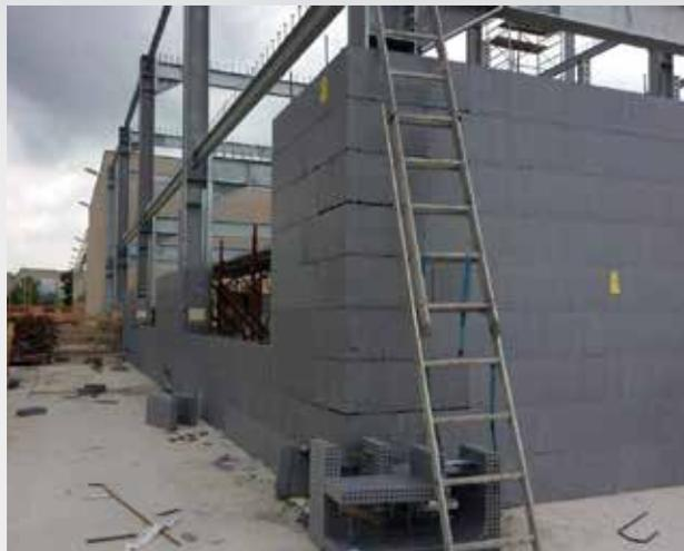
La tecnologia **ARGISOL** può essere utilizzata anche come casseforma per **realizzare le pareti di tamponamento (non strutturali)** negli edifici con **struttura a telaio**. I vari blocchi vengono posati per corsi a chiusura dello spazio tra i vari pilastri fino al profilo inferiore delle travi con le stesse modalità esecutive di taglio e formazione del foro finestra come nell'utilizzo "standard" dell'**ARGISOL**.
