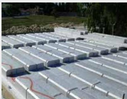
**8** Proseguire con la posa del ferro delle corree di ripartizione. Il ribassamento del pannello viene già effettuato in stabilimento.
