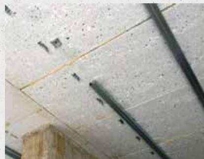
**12** A maturazione del calcestruzzo, togliere le banchine sottostanti. L'intradosso è pronto per la finitura ad intonaco o fissaggio del cartongesso.
