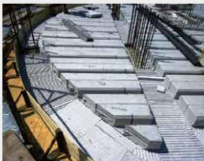
**5** Disporre nel fondo cassero delle travi a spessore le **Lastre Sottotrave** per isolare tutta la struttura di piano. Le lastre sono sagomate a coda di rondine.
