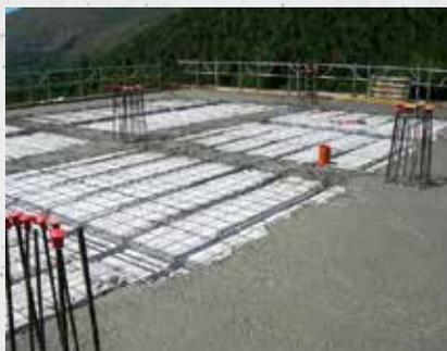
**11** Proseguire il getto del calcestruzzo con la soletta (cappa) di completamento e livellare a staggia per una superficie complanare.
