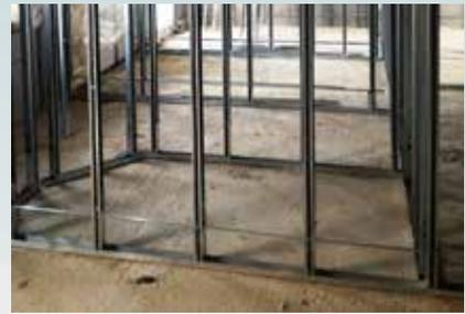
**3** Posizionare i **montanti verticali** ogni 60 cm accorciati di 1 cm rispetto l'altezza di piano. Applicare le guarnizioni monoadesive ai montanti.
