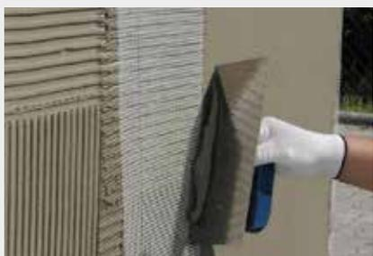
**4** Applicare la seconda mano di rasante **BIO-RAS** a copertura completa della rete. Lischiatura a frattazzo.
