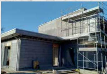
**1** Applicazione dei profili parapigolo **BIO-PROFIL** con rete integrata a protezione di sporgenze e rientranze. Rinforzare gli angoli dei fori.
