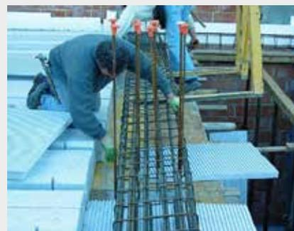
**6** Posare le armature delle travi distanziando opportunamente i ferri dalle **Lastre Sottotrave** a garanzia del copriferro.
