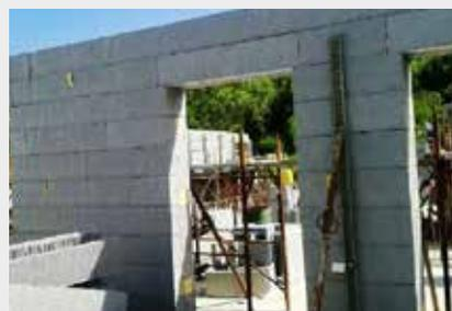
**9** In sommità delle aperture (se previsto) disporre l'elemento *Architrave*, in modo da isolare termicamente la sommità del foro finestra o porta.
