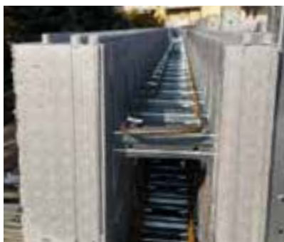
Alloggiamento delle barre orizzontali.
