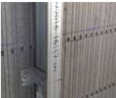
Fissaggio delle lastre in cartongesso.
