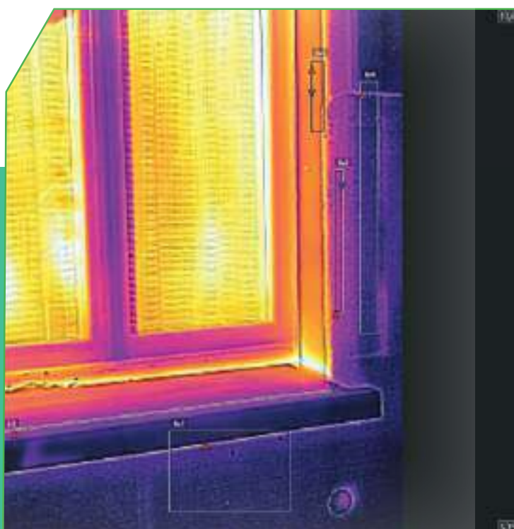
Vista esterna del serramento anni 70 con utilizzo della Termosoglia.
