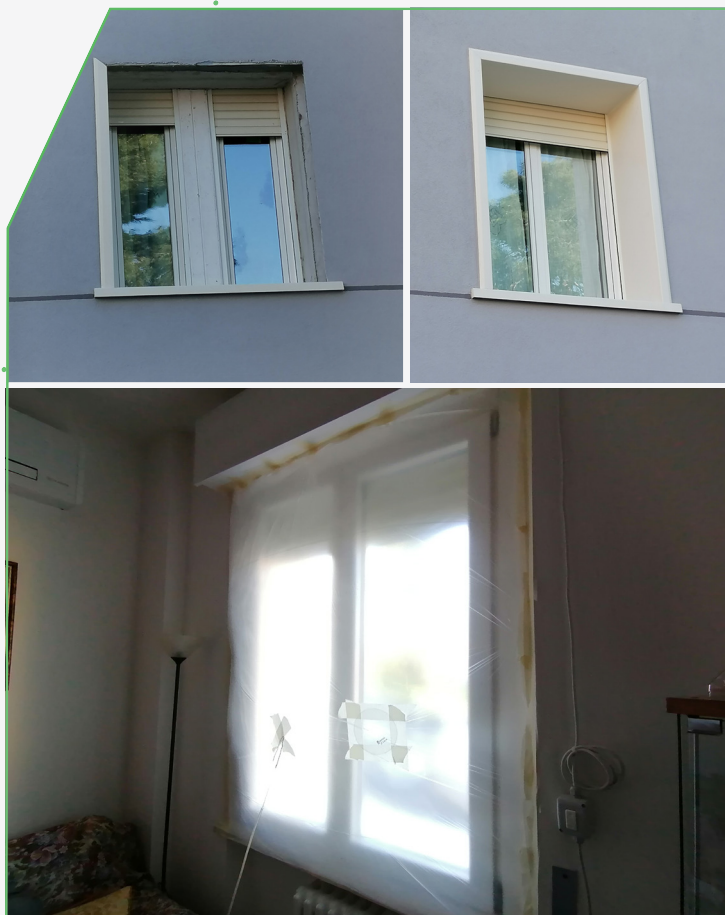
Images de tests in situ de contrôle des infiltrations d'air.
